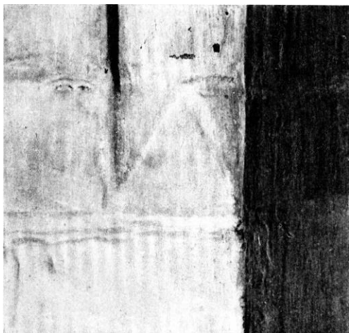
Fig. 183. Langhusets vestvæg. Endeknop på hjørnestav på vægpillen i søndre sideskibskade (p. 192). — West wall of the nave. Terminal boss on the corner fillet of the pilaster of the arcade of the south side aisle.
