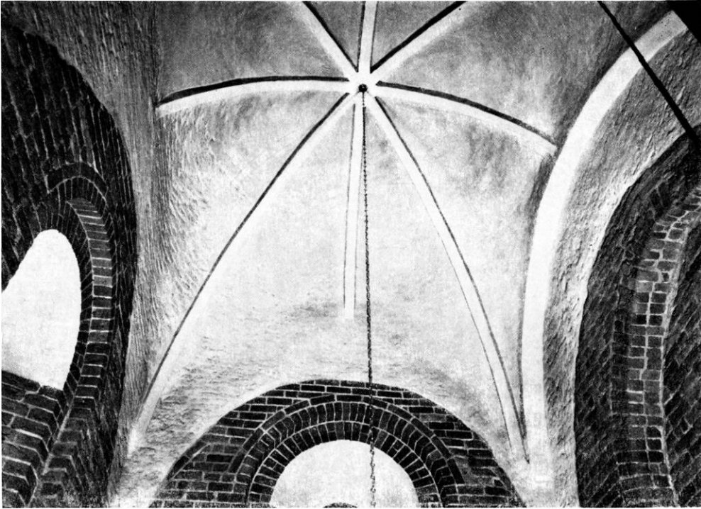
Fig. 73. Nordligste ostkapel, rummets ovre del og det sekundære hvælv med retkantede halvstensribber, set mod øst (p. 187 -89). Til højre den tilmurede arkade mod nordre apskapel. — East chapel furthest to the north, vaulting looking towards the east.
