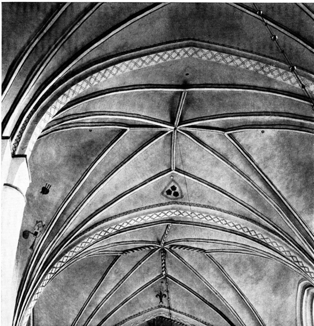
Fig. 115. Udsnit af midtskibets hvælv, midterste fag, set fra vest. — Section of the vaulting of the nave, middle bay, seen from the west.
