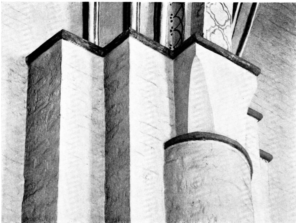
Fig. 113. Toppen af vestligste hvælvpille på midtskibets nordside (p. 243, 245). — Top of the vaulting pier furthest to the west on the north side of the nave.
