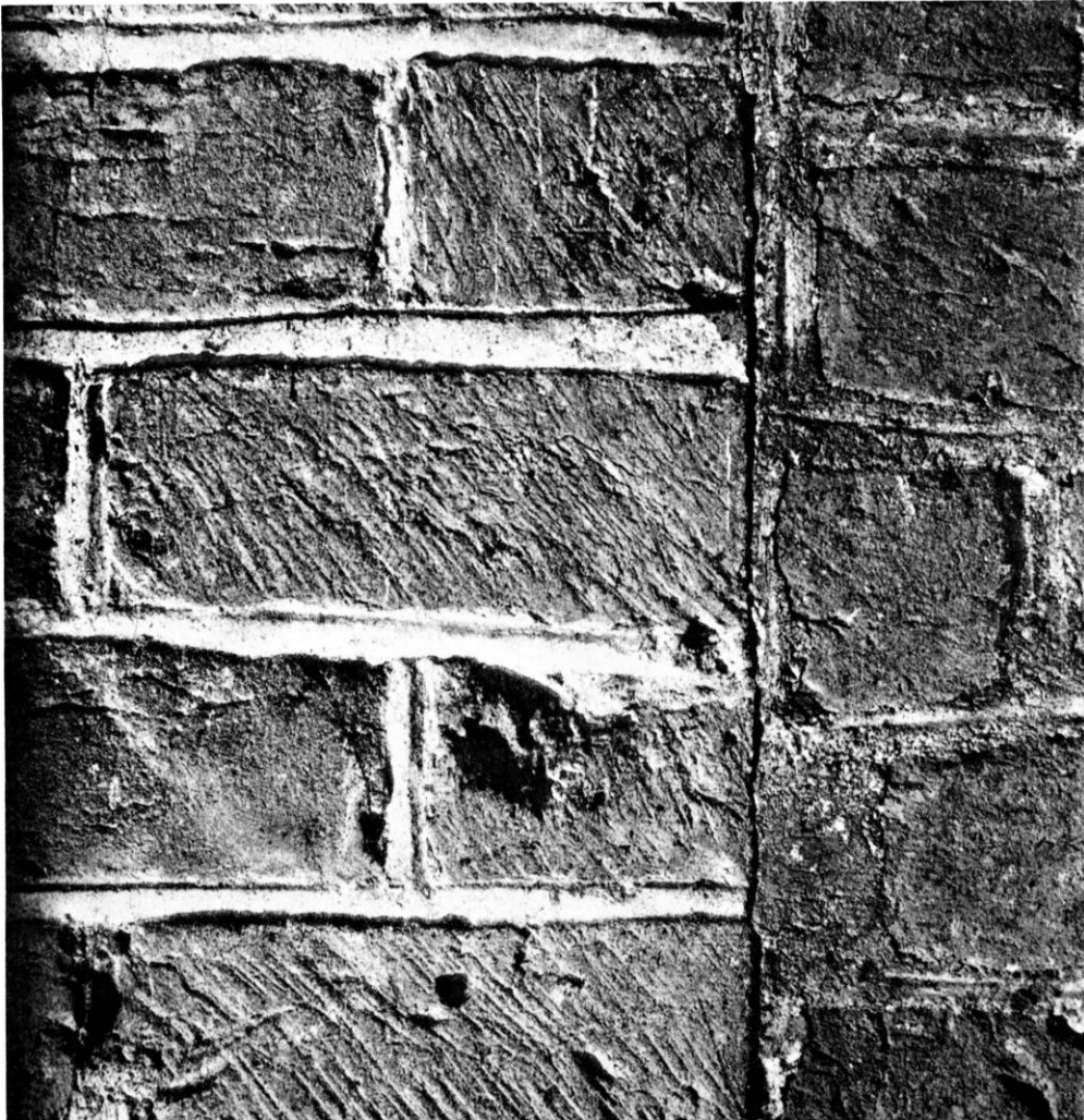
Fig. 118. Nordre korsarm, udsnit af murværk på gavlens inderside (p. 247) med tilmuring (t.h.) af oprindelige, vestlige vindue (p. 118, 149). North transept, section of masonry on the inner side of the gable with the walled-up (on the right) original west window.
