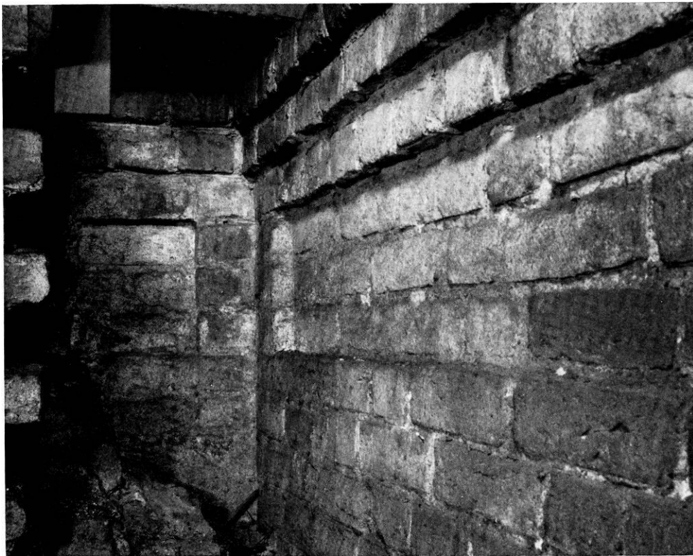
Fig. 122. Murkronen med båndblændinger i hjørnet mellem søndre korsarm (t.v.) og søndre højmur over korets midtskib, jfr. fig. 123 (p. 247). Fortandingen til venstre hidrører fra en murpåføring, udført ved korets endelige udvidelse. — The crown of the wall in the corner between the south transept (left) and the south wall above the middle aisle of the choir, cf. fig. 123.
