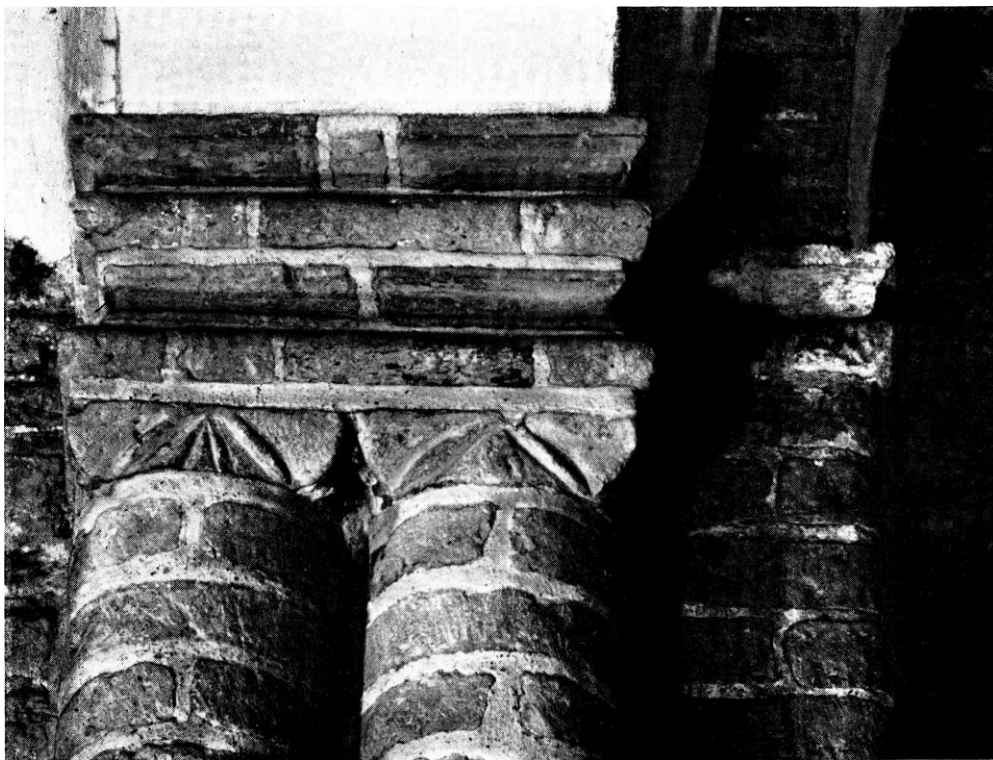
Fig. 72. Nordre apsiskapel, toppen af sydvæggens dobbelte halvsøjler og de fire skifter høje krægbånd af formsten, som danner søndre gjordbuevederlag (p. 182-83). — North apse chapel, double half-columns and south springing of the transverse rib.
