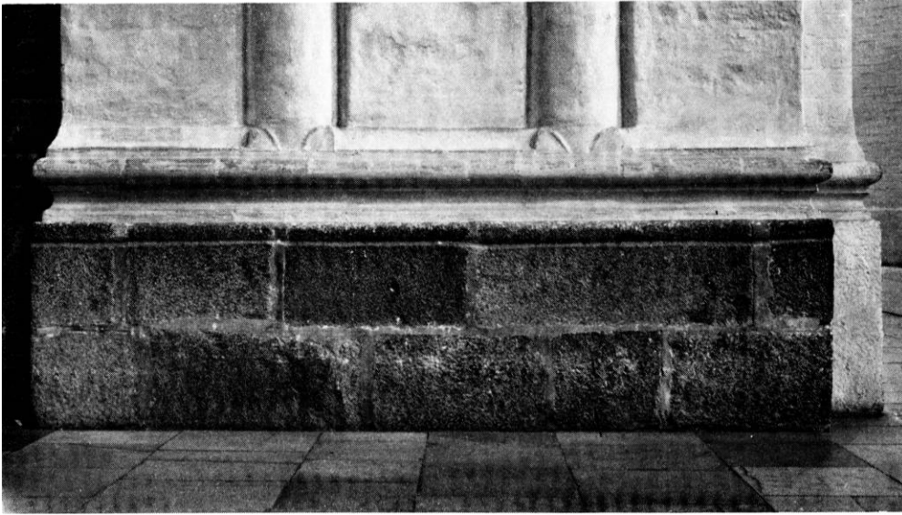
Fig. 39. Soklen på pillen i nordre korsarm mellem apsiskapellet og koromgangen (p. 142). — Plinth of the pier on the north transept between the apse chapel and the ambulatory.
