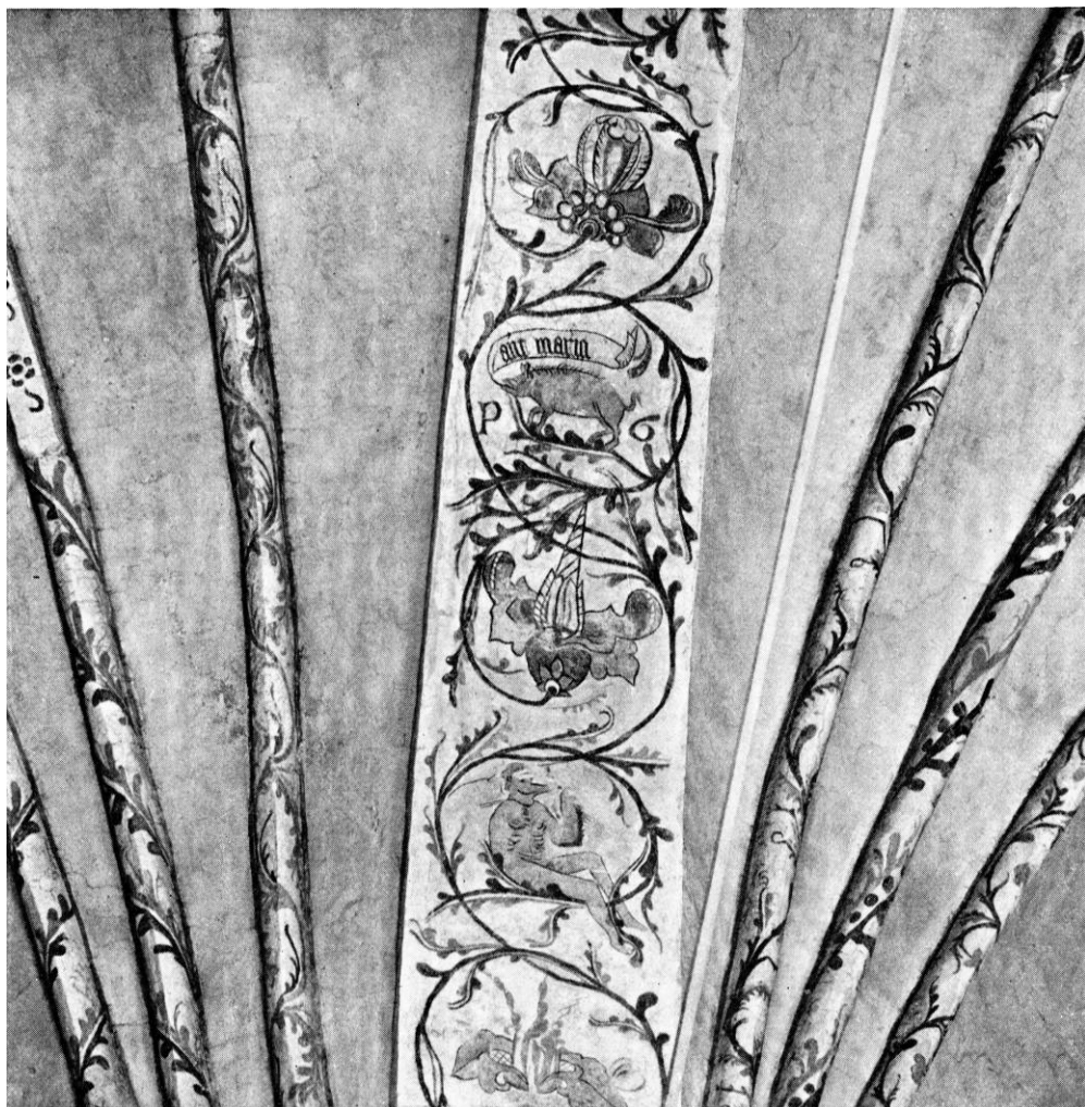
Eig. 246. Koret. Parti af næstøstligste gjordbue med tilstødende ribber, nordre del. Ranker og figurer (p. 448). — Chancel. Part of reinforcing rib second from east with adjoining ribs, north part. Vines and figures.
