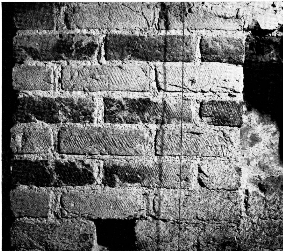
Fig. 83. Udsnit af midtpillen i sydsidens østligste, oprindelige højkirkevindue (p. 202). - Section of middle pier in the original east window in the nave on the south side.
