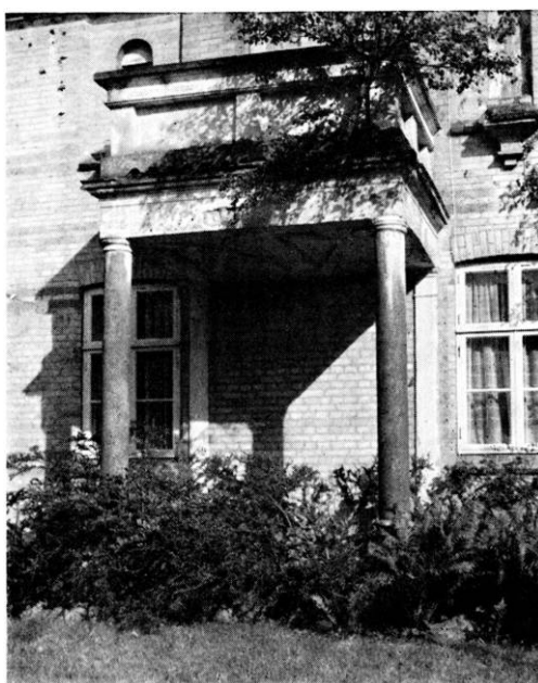
Fig. 188. St. Ravnsbjerg, Viby ved Århus. Granit-søjler som altanbærere på hovedbygningens nord-side (p. 276 med note 168). — St. Ravnsbjerg, Viby near Århus. Granite columns as supports for a balcony on the main building.
