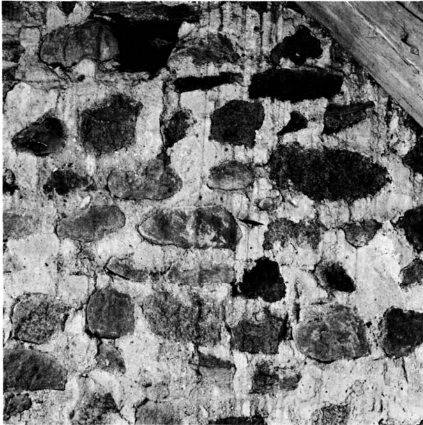
6. Brabrand. Udsnit af murværket på skibets østgavl (p. 1521). — Section of masonry in the east gable of nave.
