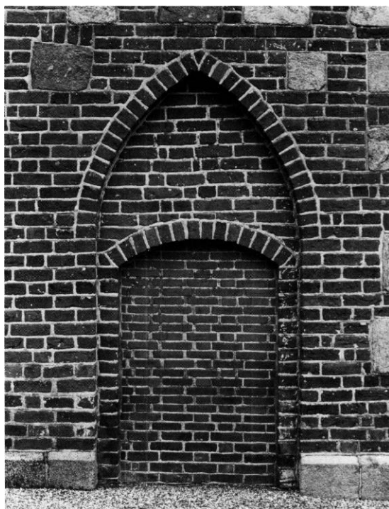
Fig. 7. Tilmuret dør i tårnets nordmur (s. 1802). NJP fot. 1980. - Walled-up door in north wall of tower.
