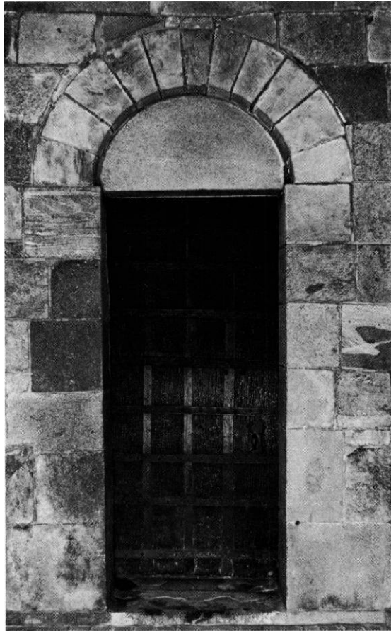
Fig. 7. Sydportal (s. 1905) med senmiddelalderlig dørføj (s. 1918). NJP fot. 1981. - South door with Late Medieval door leaf.
