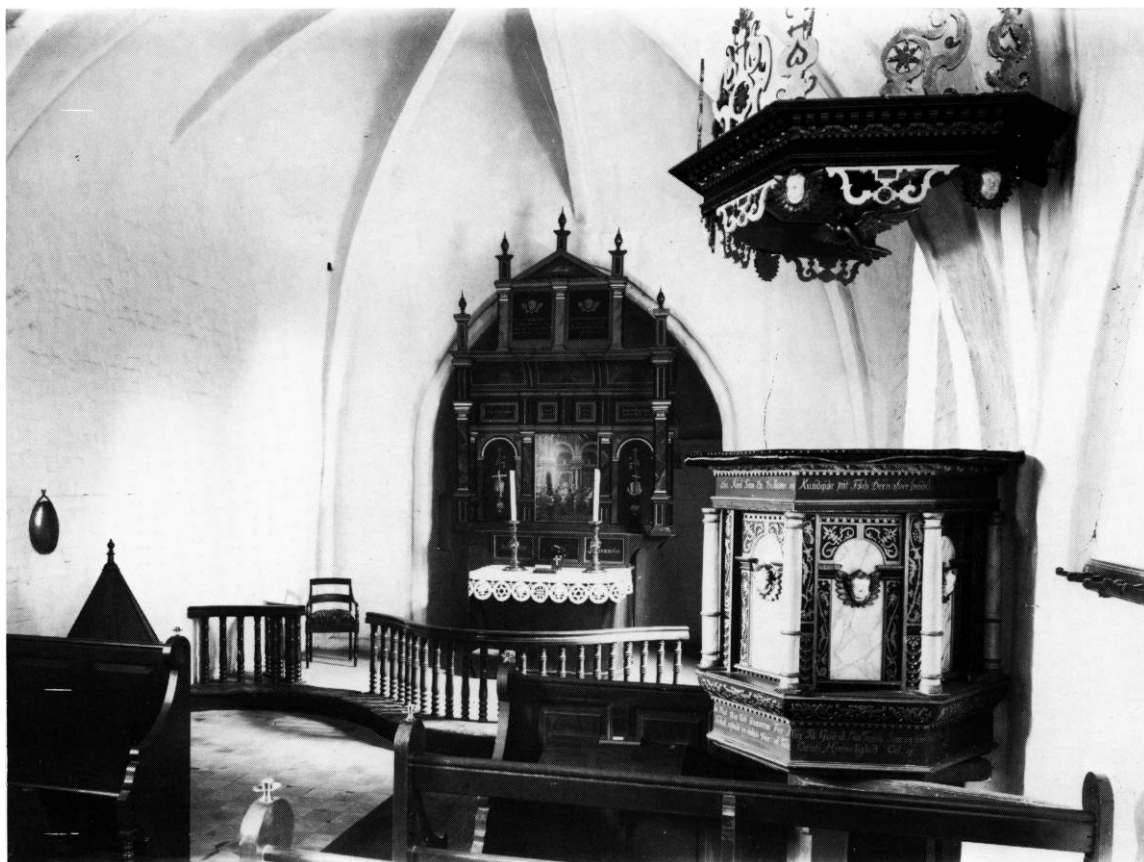
Fig. 13. Indre af koret 1908. Hude fot. 1908. - Interior of the chancel 1908.
