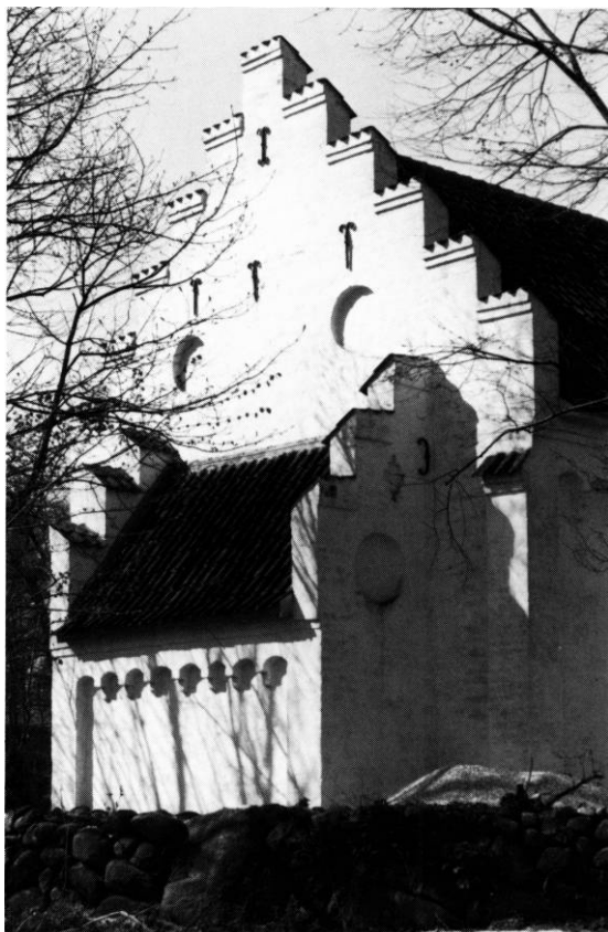
Fig. 6. Langhuskorets østgavl med sakristi (s. 2157). NJP fot. 1982. - East gable of chancel with sacristy.
