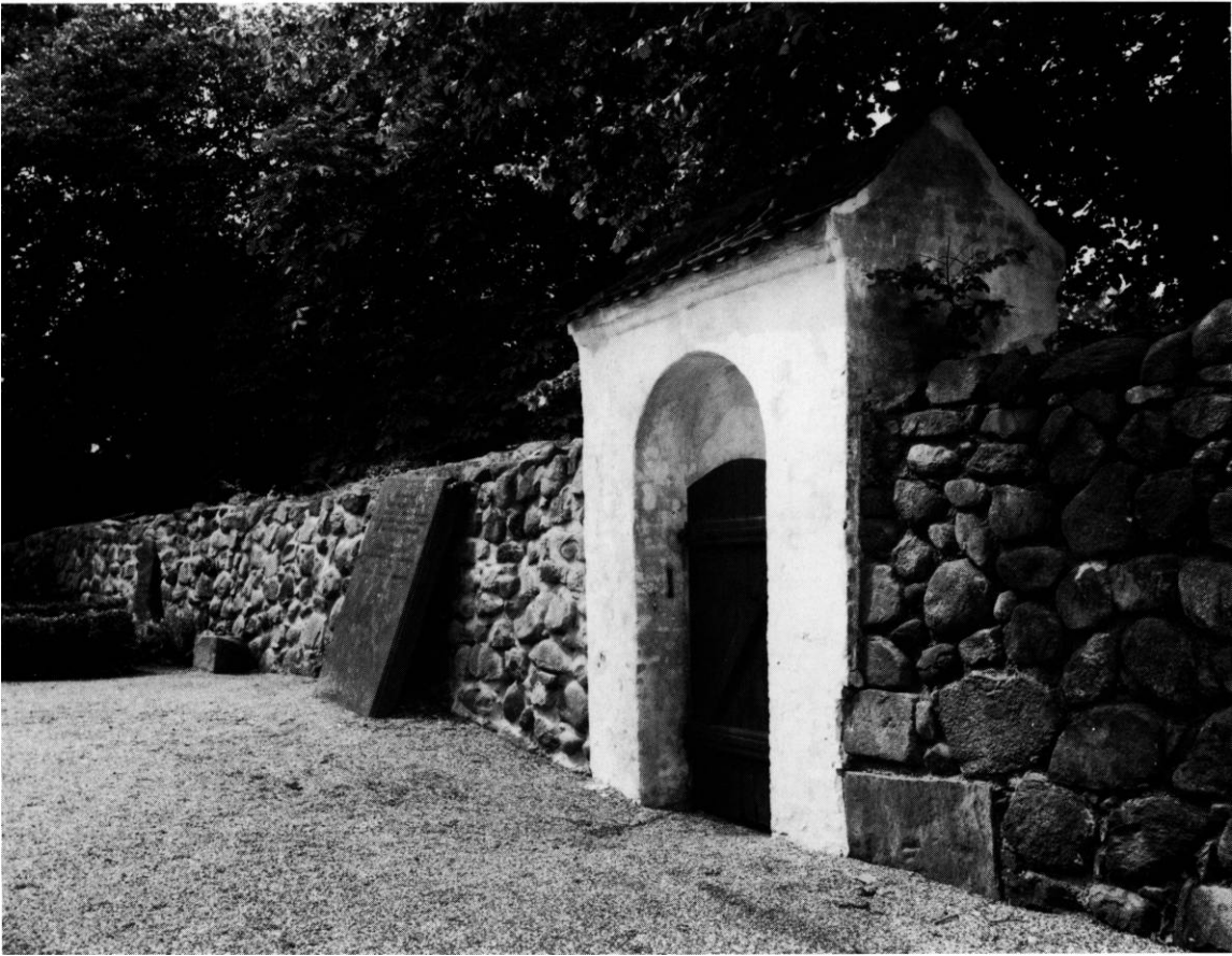
Fig. 5. Vestre kirkegårdsmur og portal, indersiden set fra nord (s. 2254). NE fot. 1980. - West churchyard wall and portal, inner side seen from north.
