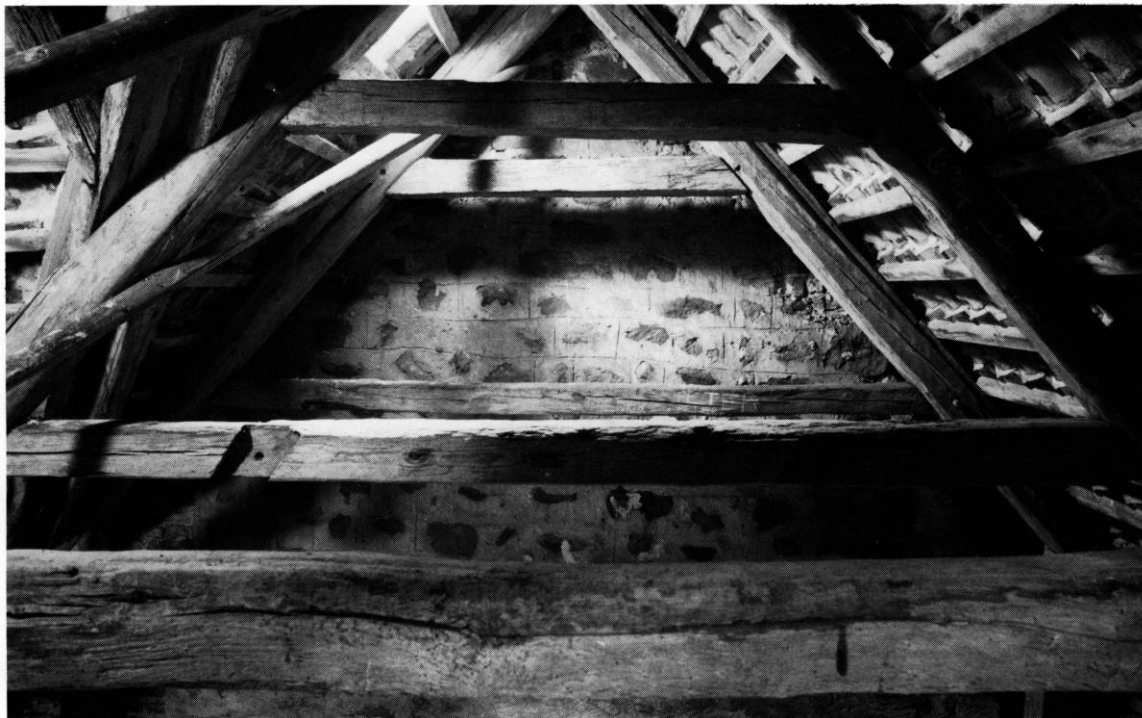
Fig. 18. Korets tagværk og gavl med kvaderridsning, set fra vest (s. 2310). JJF fot. 1980. - Chancel roofing and gable with scoring of ashlar, seen from west.
