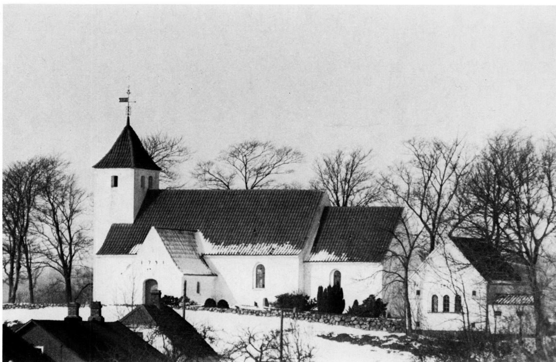
Fig. 10. Kirken set fra sydøst. Til højre ligkapellet fra 1912, der 1974 blev ombygget efter tegning af H. P. Holm Nielsen (s. 2362). Helge Jacobsen fot. 1973. – Church seen from the south-east.
