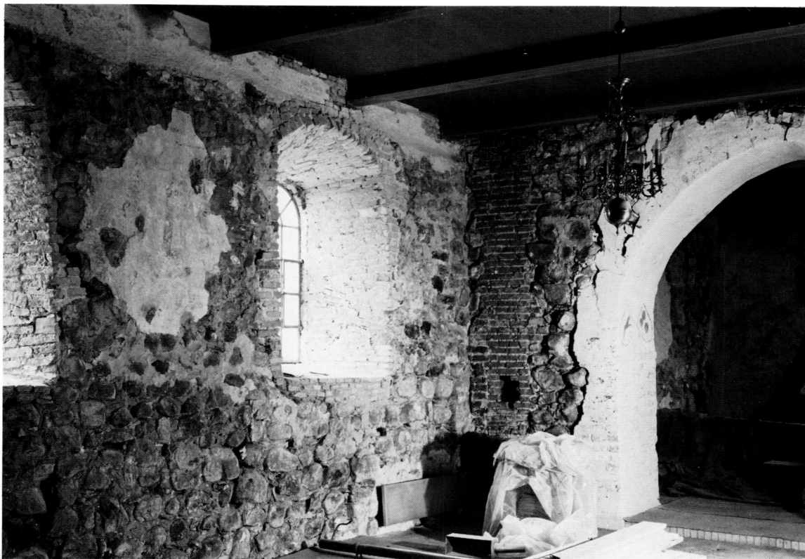
Fig. 6. Skibets indre under istandsættelse set mod nordøst. Murstenene i hjørnet tilhører skorstenen, der nu er ude af brug. Olaf Olsen fot. 1971. – Interior during restoration 1971, looking north-east.
