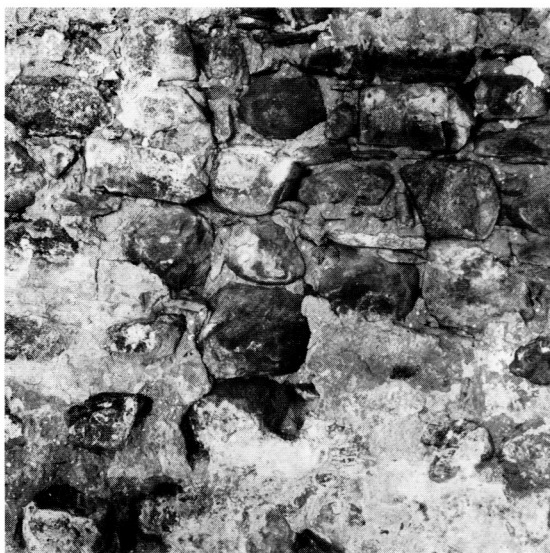
Fig. 7. Udsnit af det oprindelige murværk midt på skibets sydvæg, hvor flækker og flade sten er lagt mellem markstenshorisonterne (s. 2363, jfr. fig. 8). KdeFL fot. 1971. – Detail of masonry on the south wall of the nave.
