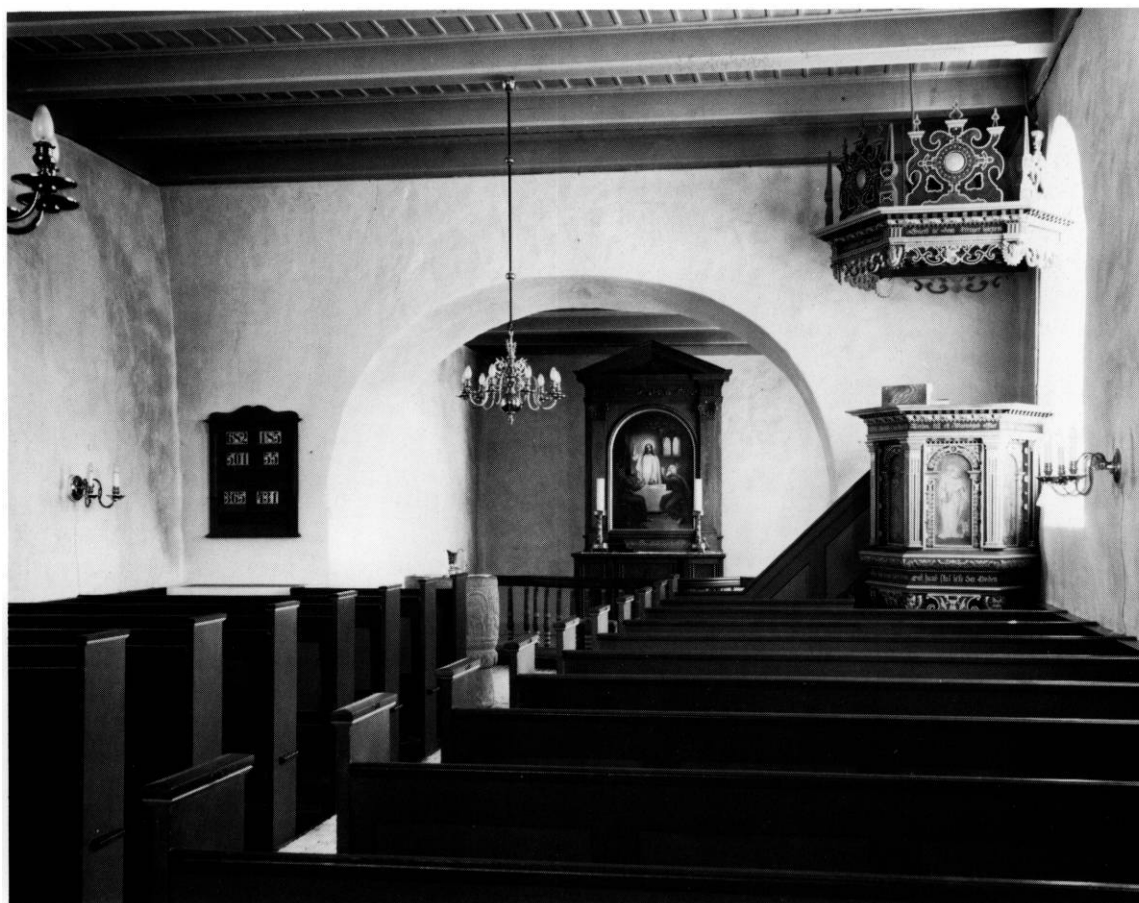
Fig. 9. Indre, set mod øst 1981 før restaureringen. NE fot. 1981. - Interior looking east 1981 before the restoration.
