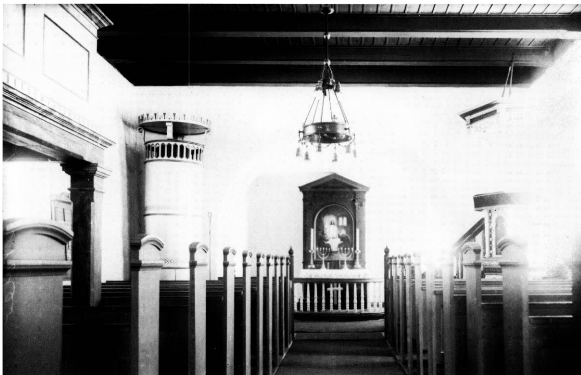
Fig. 5. Indre, set mod øst. Fotografi omkring 1918 i Det kgl. Bibliotek. - Interior looking east.
