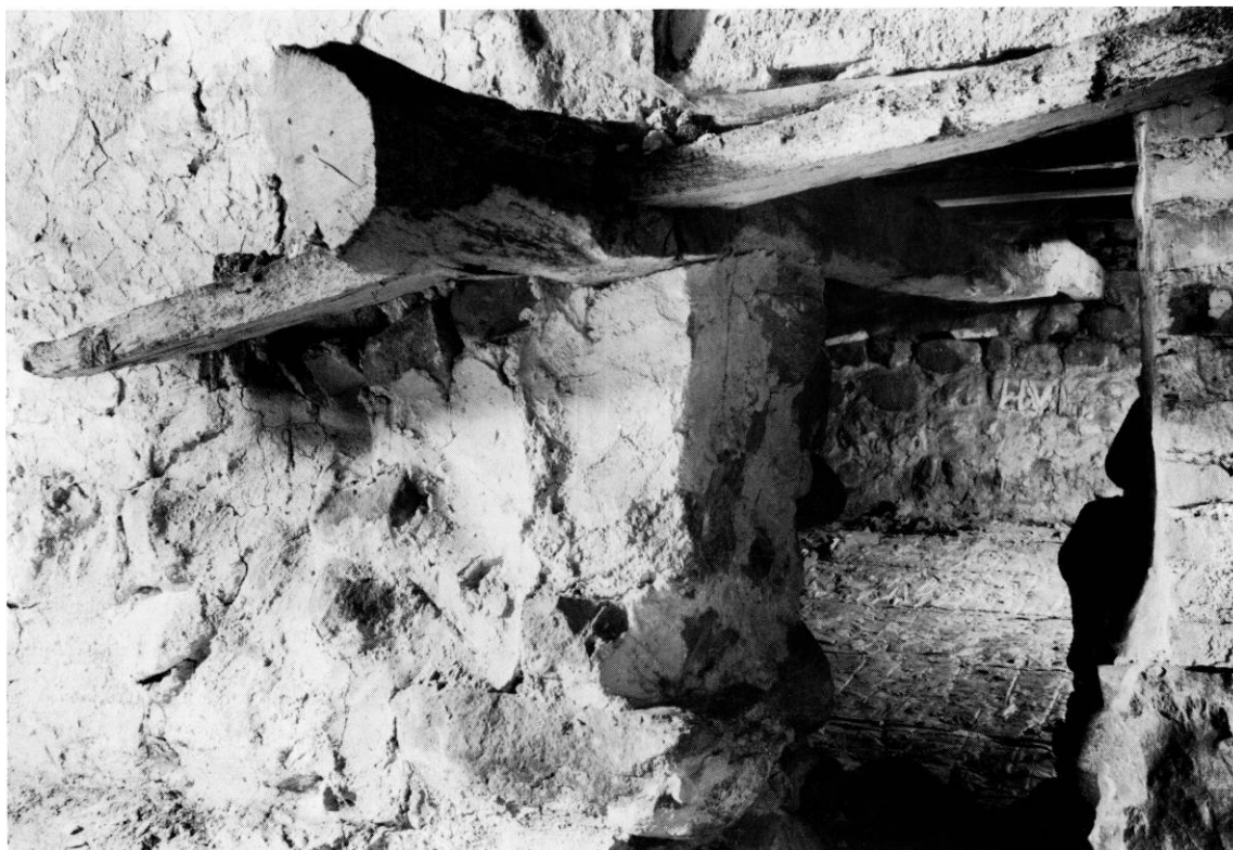
Fig. 17. Ankerbjælke på korets loft, set fra skibet (s. 2471). J.J.F. fot. 1981. - Anchored beam on the ceiling of the chancel as seen from the nave.
