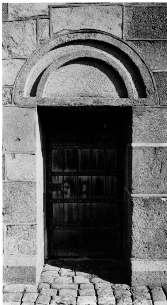
Fig. 9. Døren i korets sydside (s. 2651) genåbnet 1931 og forsynet med dørfløj. NE fot. 1981. — Door at the south side of the chancel.
