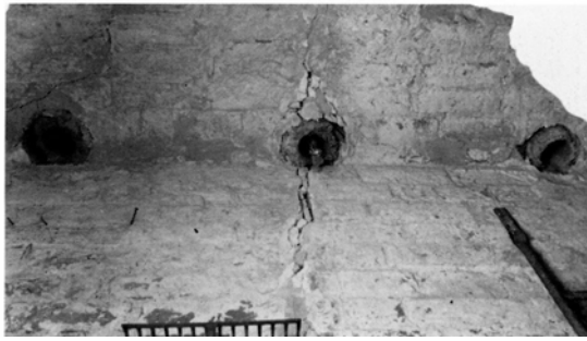
Fig. 13. "Klokkerkammeret" i tårnets vestre mur, udsnit af østvæggen og hvælv med klokkerebshuller (s. 2654). NE fot. 1981. - The "bell-ringer's cell" in the west wall of the tower. The vault with holes for ropes.
