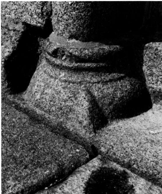
Fig. 14. Syddørens vestre søjlebase (s. 2754). KdeFL fot. 1986. - The west plinth in the south portal.
