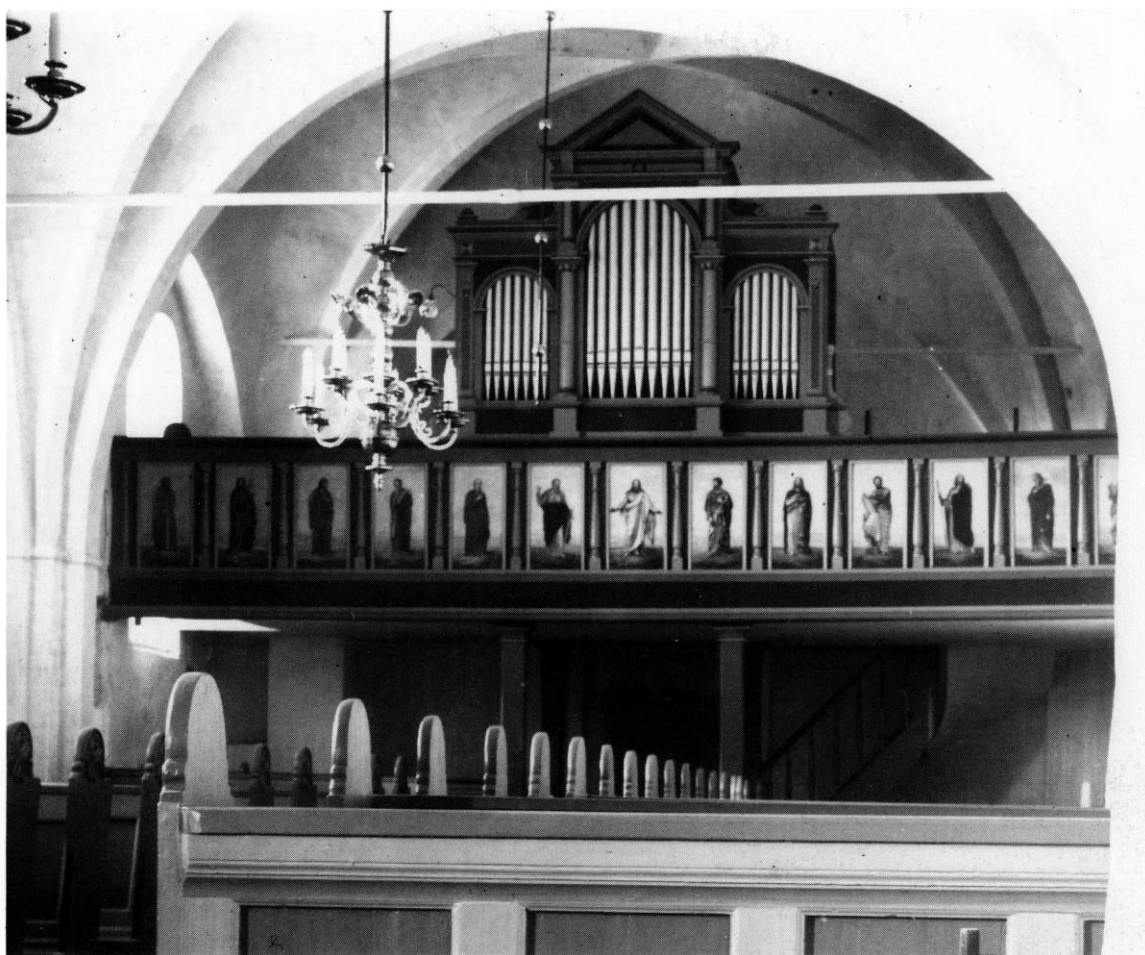
Fig. 9. Indre set mod vest. Ældre fotografi i NM. - Interior to the west.
