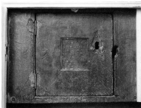
Fig. 26. Skab fra 1500rne (?), i korets nordvæg (s. 3168). NE fot. 1985. - Cupboard from the 16th century (?) in the north wall of the chancel.
