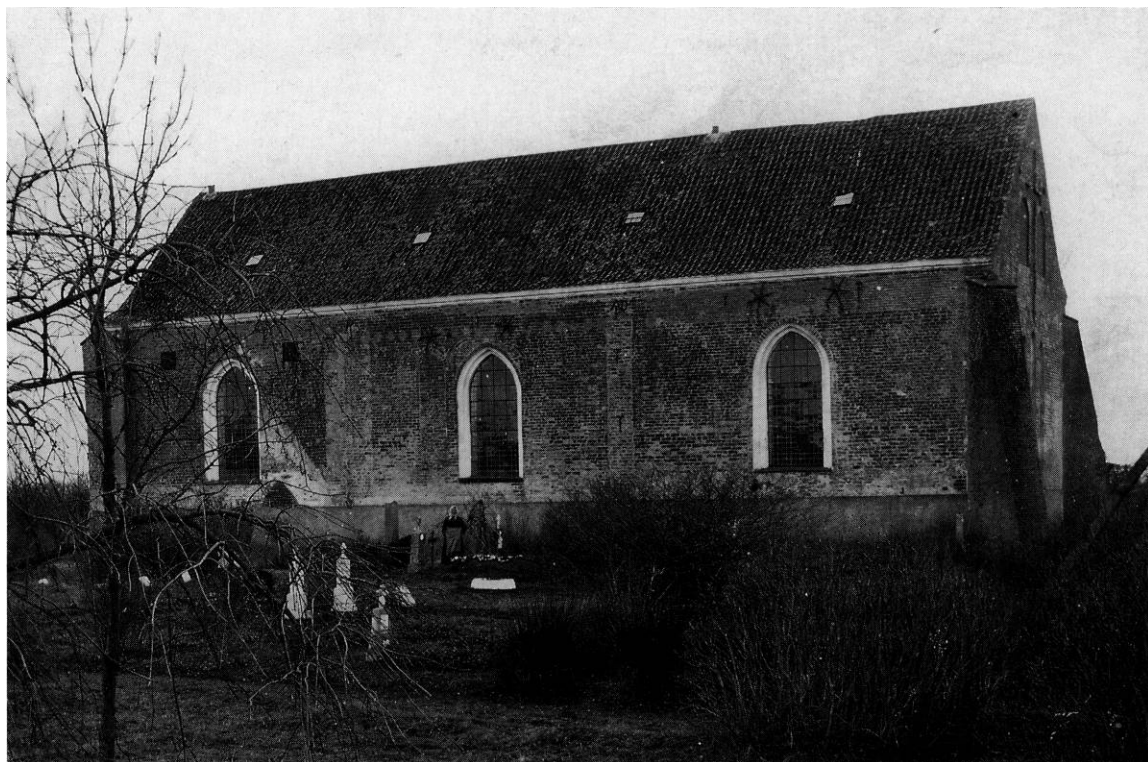
Fig. 4. Kirken set fra sydøst. Fot. o. 1900 i Lokalhitorisk arkiv i Gjærn. - The church seen from the south-east.
