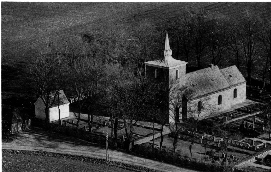
Fig. 8. Kirken set fra sydvest. Aalborg luftfoto o. 1950. Det kgl. Bibliotek. - The church seen from the south-west.
