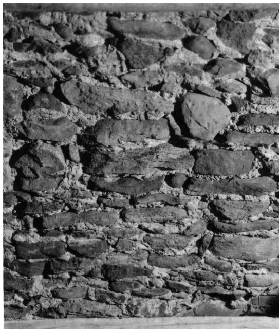
Fig. 3. Udsnit af murværket på indersiden af korets østgavl (s. 3628). KdeFL fot. 1991. - Section of masonry on the inner face of the chancel gable.
