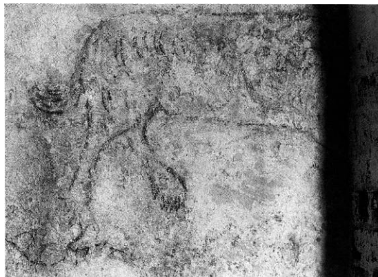
Fig. 8. Sorttegnet dyrefigur fra 1200me, jfr. fig. 27, på skibets nordvæg, nu overkalket (s. 3918). Henrik Græbe fot. 1990. - Animal, 13th century, cf. fig. 21, on the north wall of the nave.
