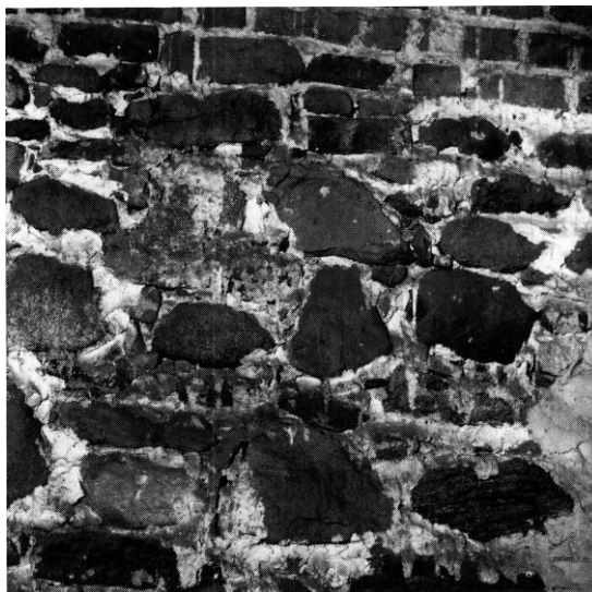
Fig. 9. Udsnit af vestsiden af skibets østgavl (s. 4019). KdeFL fot. 1993. - Section of masonry on the west side of the nave's east gable.
