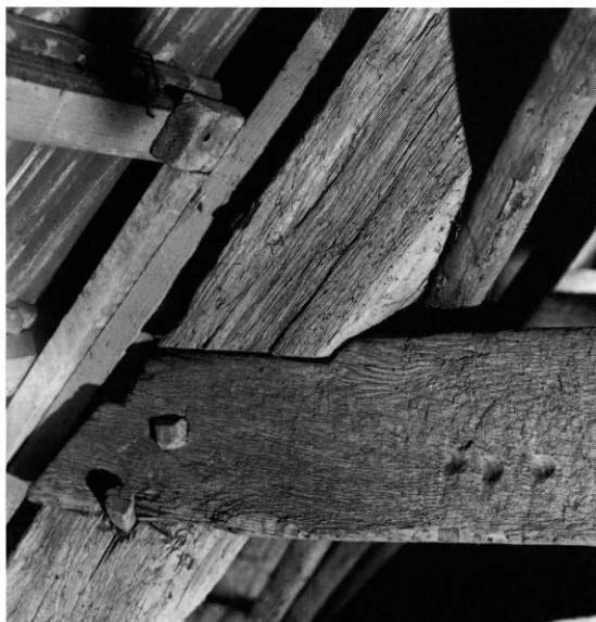
Fig. 15. Detalje af korets tagværk, samling med »krumkonsol« mellem spær og hanebånd, tredje fag fra vest (s. 4026). KdeFL fot. 1993. - Detail of the chancel's roof truss between rafter and tie-beam.
