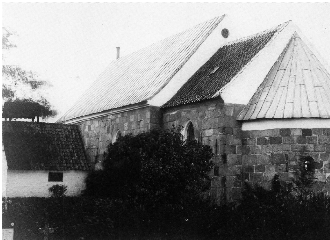
Fig. 35. Kirken set fra sydøst. Over kippen på våbenhuset ses klokkestabelens tag, jfr. fig. 2. Foto omkring 1890 i NM. - The church seen from the south-east. Above the porch can be seen the roof of the former belfry, cf fig. 2.
