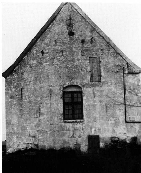
Fig. 33. Skibets vestgavl med bl.a. Frederiks V.s navnetræk (s. 4083) og lem til loftet (s. 4102, note 29). Foto 1927 i NM. - The gable of the nave before construction of the tower.
