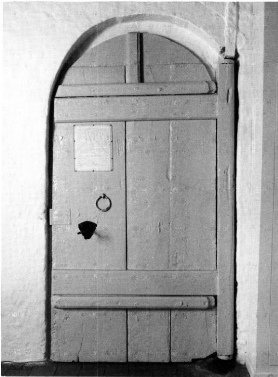
Fig. 23. Dørfløj fra 16-1700rne, mellem skib og våbenhus, set fra våbenhuset (s. 4172). NE fot. 1993. - Door, 17th-18th century, between the nave and the porch.
