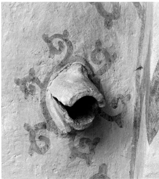
Fig. 8. Nordvestre afløbshul i korets hvælv (s. 4397). Henrik Wichmann fot. 1995. - Outlet pipe in the chancel vault.
