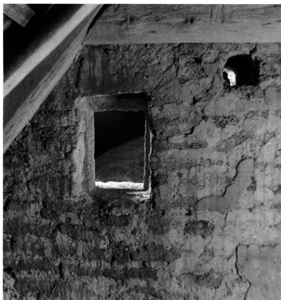
Fig. 17. Udsnit af triumfmurens taggavl, søndre side set fra øst (s. 4552). Mogens Svenning fot. 1973. - Section of the east gable of the nave, seen from the east.
