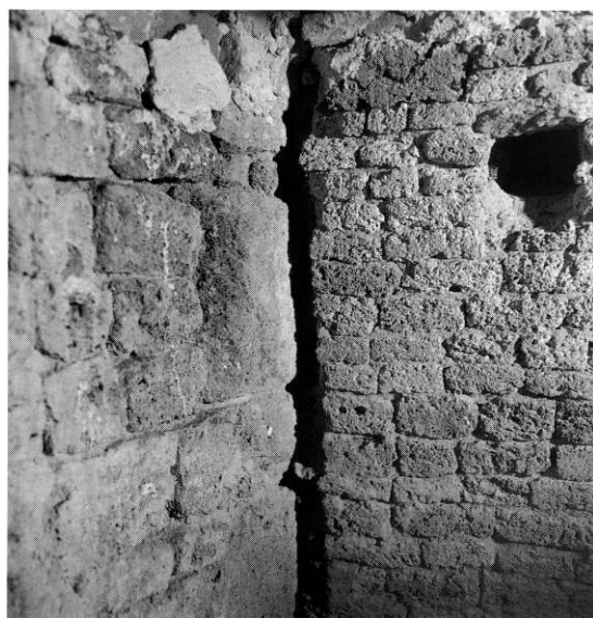
Fig. 14. Hjørnet mellem korets nord- og østmur over hvælvet (s. 4550). KdeFL fot. 1996. - The corner between the north and the east walls of the chancel, above the vault.
