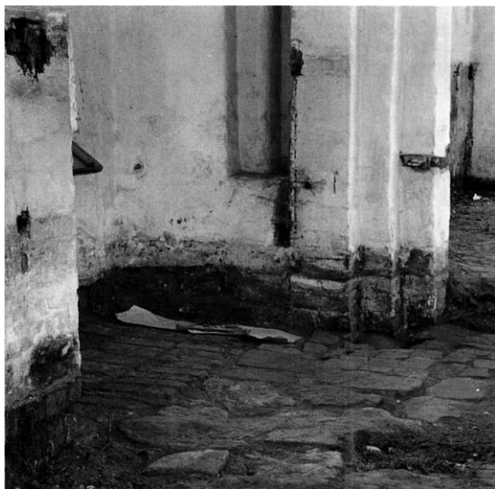
Fig. 20. Portalen i skibets sydside (s. 4553) og rester af gulv blottet under afgravning (s. 4559). Aksel Skov fot. 1960. - The south portal of the nave and remains of floor exposed in the course of restoration.
