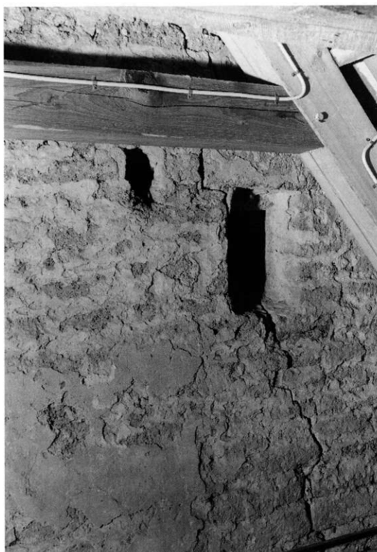
Fig. 18. Udsnit af triumfmurens taggavl, nordre side set fra øst (s. 4552) KdeFL fot. 1996. - Section of the east gable of the nave, north side, seen from the east.
