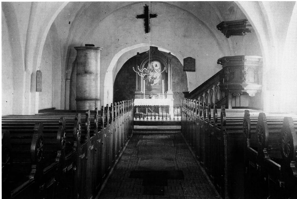
Fig. 28. Indre set mod øst o. 1900. Ældre fot. i NM. - Interior to the east, c. 1900.
