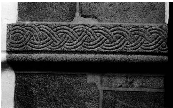
Fig. 7. Korbuens krægbånd, nordre t.v. (s. 4706). H. Wichmann fot. 1997. - The imposts of the chancel arch.
