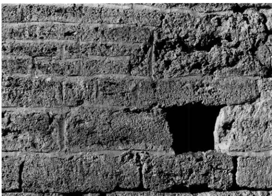
Fig. 4. Udsnit af vestsiden af triumfmurens taggavl (s. 4736). KdeFL fot. 1997. - Section of the east gable of the nave, west side.
