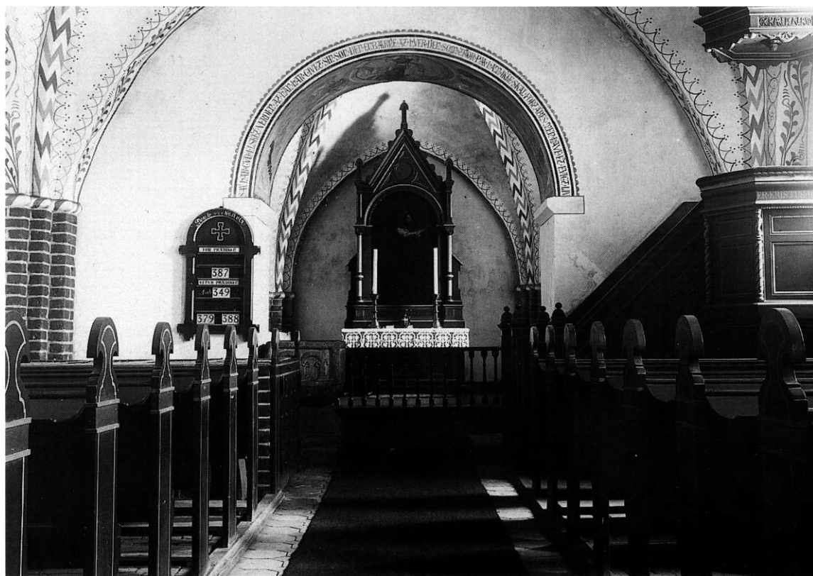
Fig. 11. Indre, set mod øst. Ældre foto i NM. - Interior to the east.
