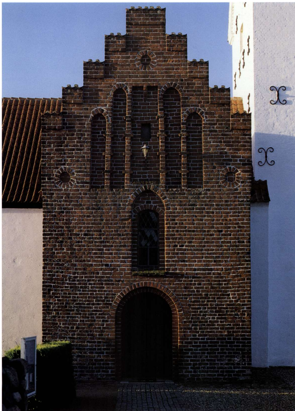
Fig. 10. Våbenhusets gavl (s. 4738). KdeFL fot. 1997. - The gable of the porch.
