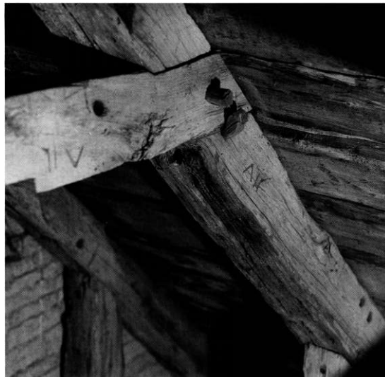
Fig. 12. Detalje fra nordsiden af korets tagværk, nummereringer og samling mellem hanebånd og spær (s. 4741). KdeFL fot. 1997. - Detail of the roof construction of the chancel. Joining of tie-beam and rafter.
