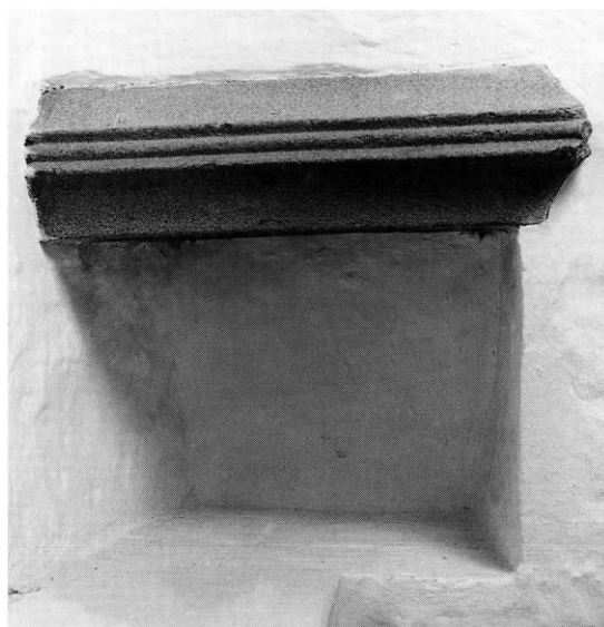
Fig. 7. Niche i triumfvæggen (s. 4773). Henrik Wichmann fot. 1997. - Niche in the east wall of nave.
