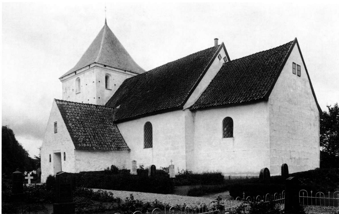
Fig. 6. Kirken set fra sydøst. Ældre fot. i Lokalhistorisk arkiv. - The church seen from the south-east.
