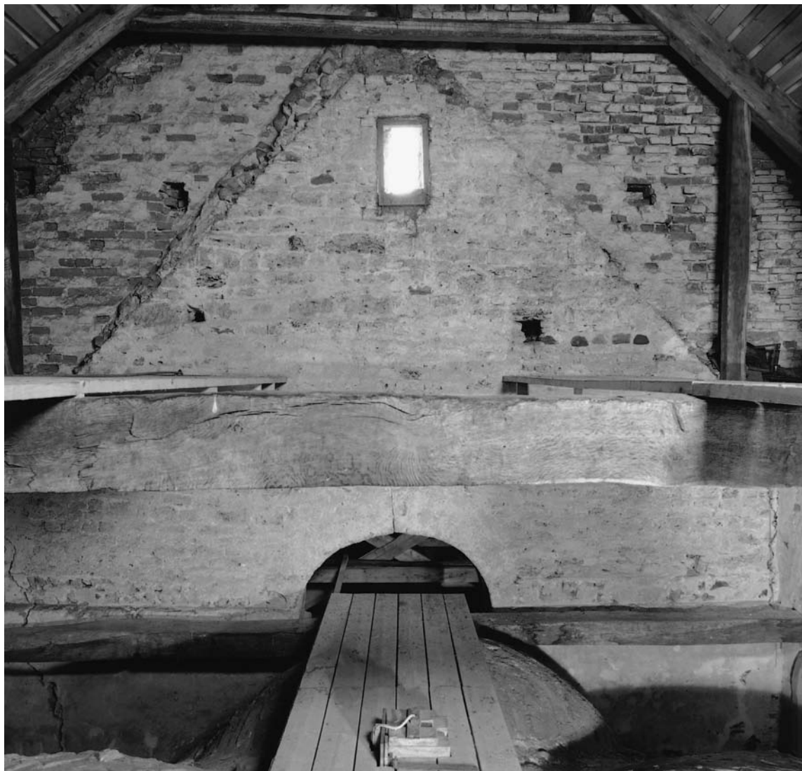
Fig. 36. Langhusets østre gavl set fra midtskibets loft (jfr. fig. 19, 20, 130 og s. 5078). I midten den øvre del af arkadeåbningen mellem højkirken og korets loftsrum (s. 5078). Over gavltrekanten ses den opragende murkerne, der må være en rest af en muret kam (s. 5079). Jesper Weng fot. 2001. – East gable of the nave seen from the ceiling of the central aisle. Centre: the upper part of the arcade opening between the nave and the chancel loft. Above the gable triangle, one can see the projecting core of a wall, which must be the remains of a crest (cf. figs. 19, 20, 130).
