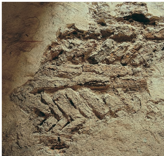
Fig. 22. Frådstensmurværk i sildebensmønster i højkirkens sydvæg (s. 5068). Jesper Weng fot. 2001. – Calcareous tufa masonry in herringbone pattern in the south wall of the nave.
