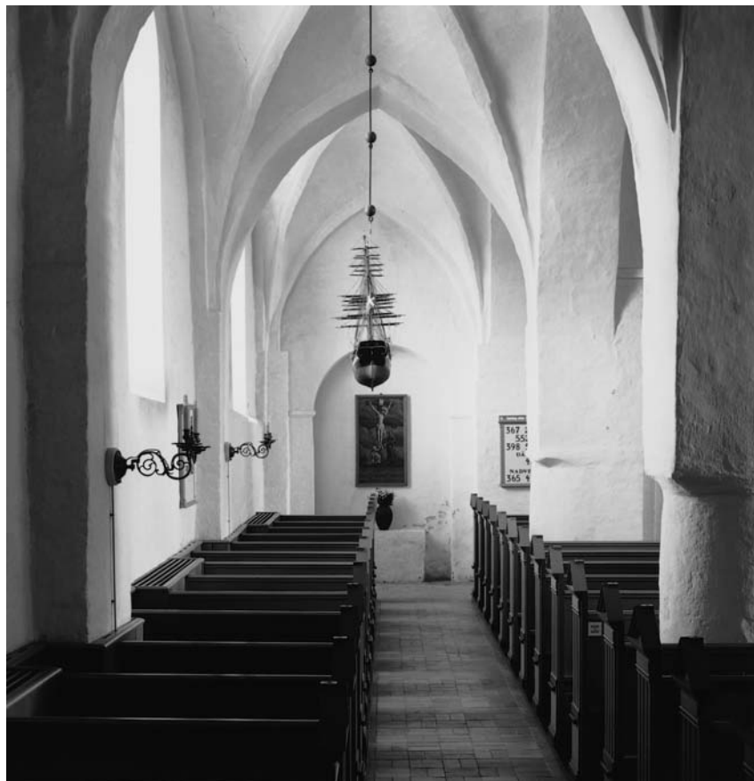
Fig. 46. Nordre sideskibs indre set mod øst før seneste restaurering. Jesper Weng fot. 2000. – Interior of north side-aisle looking east before restoration.
