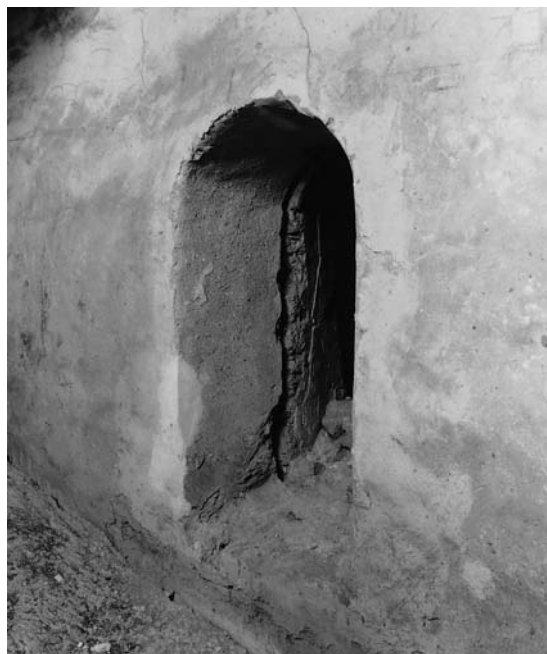
Fig. 34. Romansk vinduesåbning i højkirkens sydvæg med rille efter udtaget *vinduesramme (jfr. fig. 33 og s. 5077). Jesper Weng fot. 2001. – Romanesque window opening in the south wall of the nave with a groove from a removed *window frame (cf. fig. 33).
