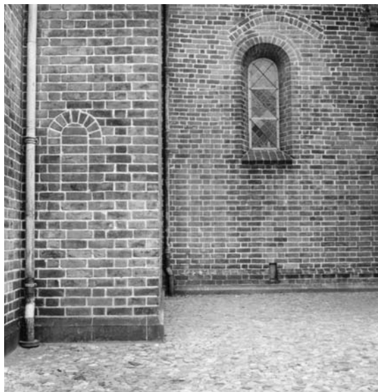
Fig. 44. Vinduesspor på skibets sydøsthjørne (s. 5417) og i korets vestfag (s. 5474). HJ fot. 2003. – Traces of windows in the southeastern corner of the nave and in the west bay of the chancel.
