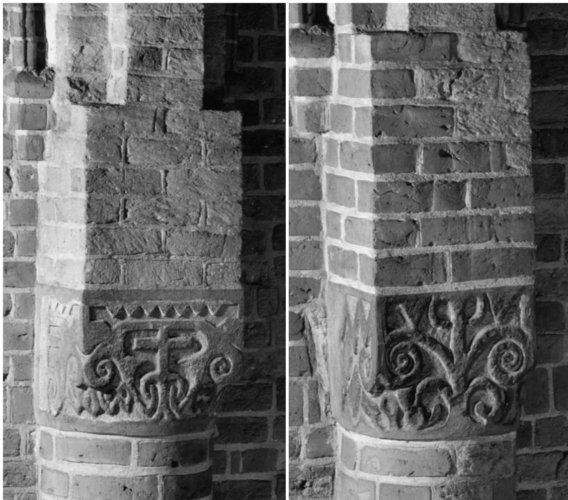
Fig. 59a-b. Granitkapitæler på midtskibets trekvartsøjler (s. 5427). a. Tredje søjle i syd. b. Første søjle i nord. HJ fot. 2002. – Granite capitals on three-quarter columns of the nave. a. Third column in the south. b. First column in the north.
