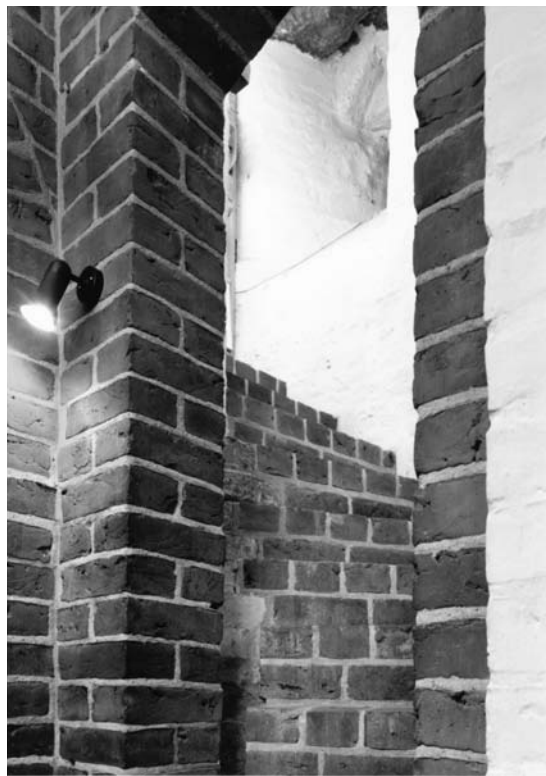
Fig. 64. (†)Trappe til vestpartiets øvre stokværk og nordre tvillingetårn (s. 5435). Henrik Wichmann fot. 2002. – (†)Stairs to the upper storey of the western section and the northern twin tower.
