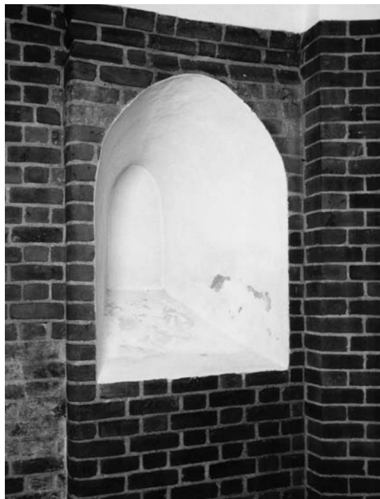
Fig. 45. ( \dagger )Blændet, sekundært udvidet vindue i vangen til nordre apsis (s. 5417). Henrik Wichmann fot. 2002. – ( \dagger ) Bricked-up, later widened window in jamb to north apse.
