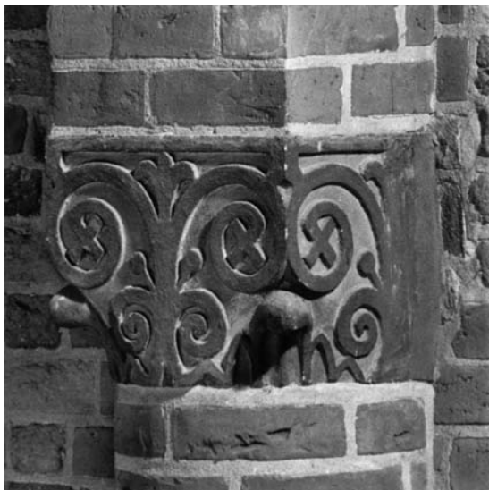
Fig. 224. Cementkapitæl 1864-66 på midtskibets 3. trekvartsojle i nord (s. 5460). HJ fot. 2002. – Cement capital, 1864-66, on third three-quarter column of the nave in the north.
