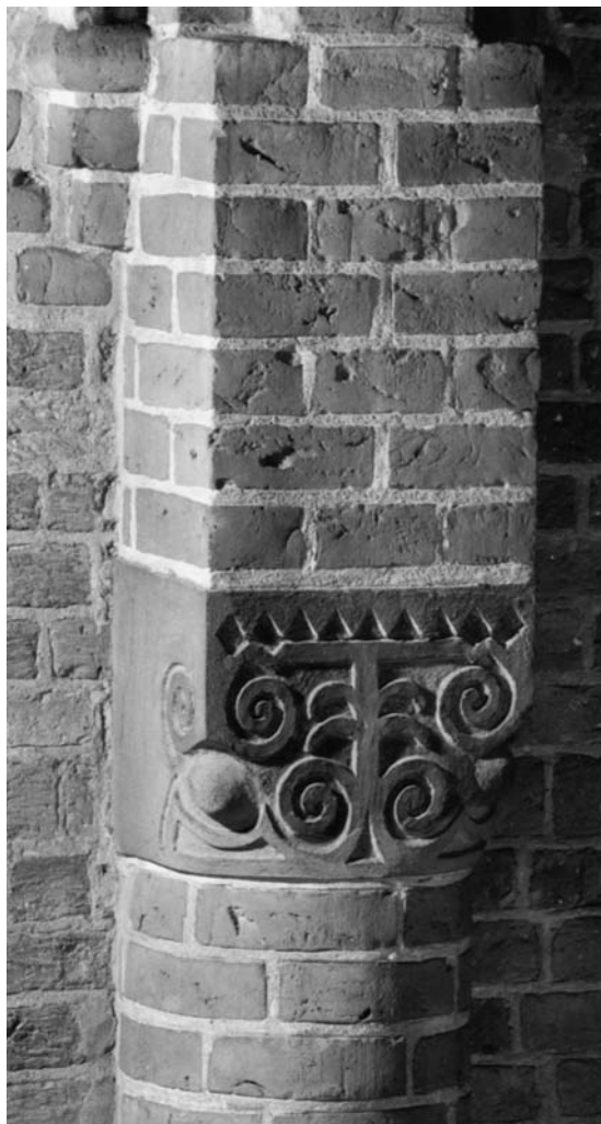
Fig. 223. Cementkapitæl 1864-66 på midtskibets 4. trekvartsojle i syd (s. 5460). HJ fot. 2002. – Cement capital, 1864-66, on the fourth three-quarter column of the nave in the south.
