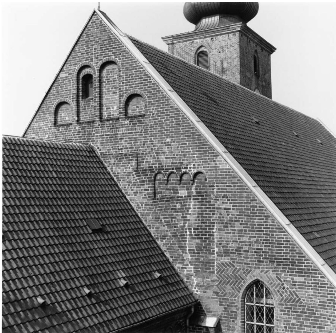
Fig. 35. Udsnit af skibets østgavl set fra nordøst (s. 5409). HJ fot. 2002. – Detail of the east gable of the nave viewed from the north east.
