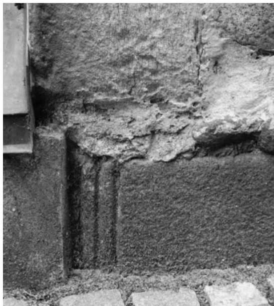
Fig. 217. Detalje af sokkel under nordre sideskibs 2. støttepille med profileret, genanvendt granitkvader (s. 5404). HJ fot. 2003. – Detail of the base of the second buttress of the north side aisle with profiled, re-used granite ashlar.
