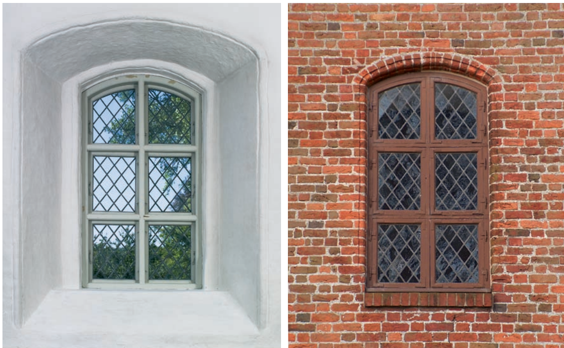
Fig. 16a-b. Østsidens tredje vindue fra nord (s. 6177). a. Indre. Foto Arnold Mikkelsen 2005. b. Ydre. Foto Mogens Vedso 2006. – Third window from the north on east side. a. Interior. b. Exterior.
