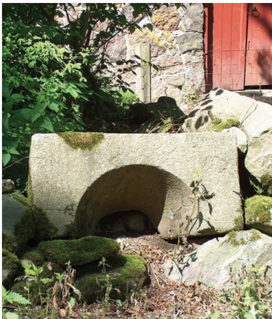
Fig. 17. Borupgård. *Romansk vinduesoverligger af granit muligvis fra †Borup Kirke (s. 6371). Foto Anders Horsbøl Nielsen 1998. – Borupgård. *Romanesque window lintel of granite, possibly from †Borup Church.
