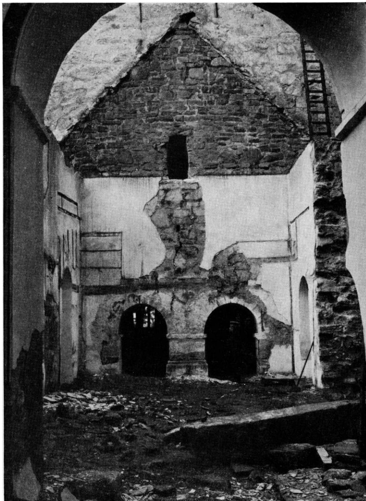
Fig. 5. S. Bodils kirke. Skibet set mod vest under MM 1911 restaureringen 1911. I forgrunden ses den store runesten, som blev fundet i nordmurens fundament, da man brød igennem ud til den moderne tværbygning (sml. s. 530).
