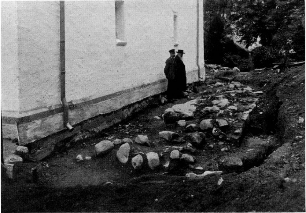
Fig. 6. S. Bodils kirke. Fundament af en mur, liggende parallelt med tårnets vestre façade (sml. s. 518).
