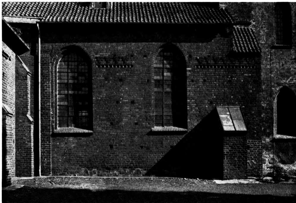
Fig. 10. S. Olai kirke. Nordre sideskibsmur mellem Oxes kapel og tårnet; murens store, nedre del med vinduesspor, savsnit og trappefrise er identisk med nordmuren i den vestforlængelse, der tillige med tårnet o. 1400—25 føjedes til den enskibede kirke (p. 60).
