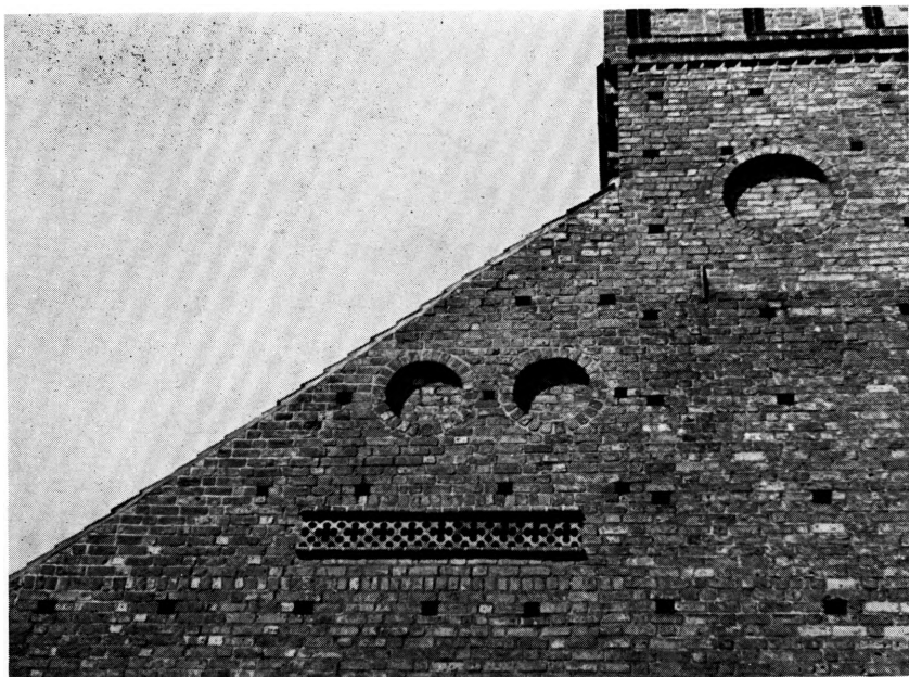
Fig. 23. S. Olai kirke. Søndre sideskibs østre taggavl med firkløverfrise (p. 75, sml. fig. 22.17).
