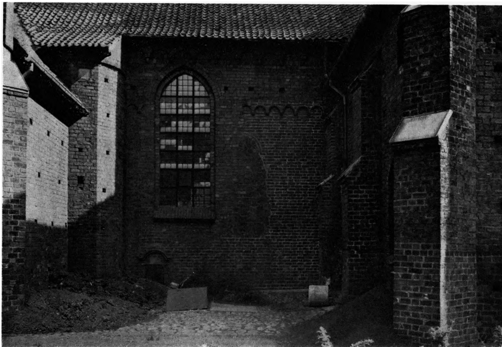
Fig. 9. S. Olai kirke. Nordre sideskibsmur mellem sakristiet og Oxes kapel; murens store, nedre del med vinduesspor og rundbuefrise er østenden af det senromanske kirkeskibs nordmur (p. 57).
