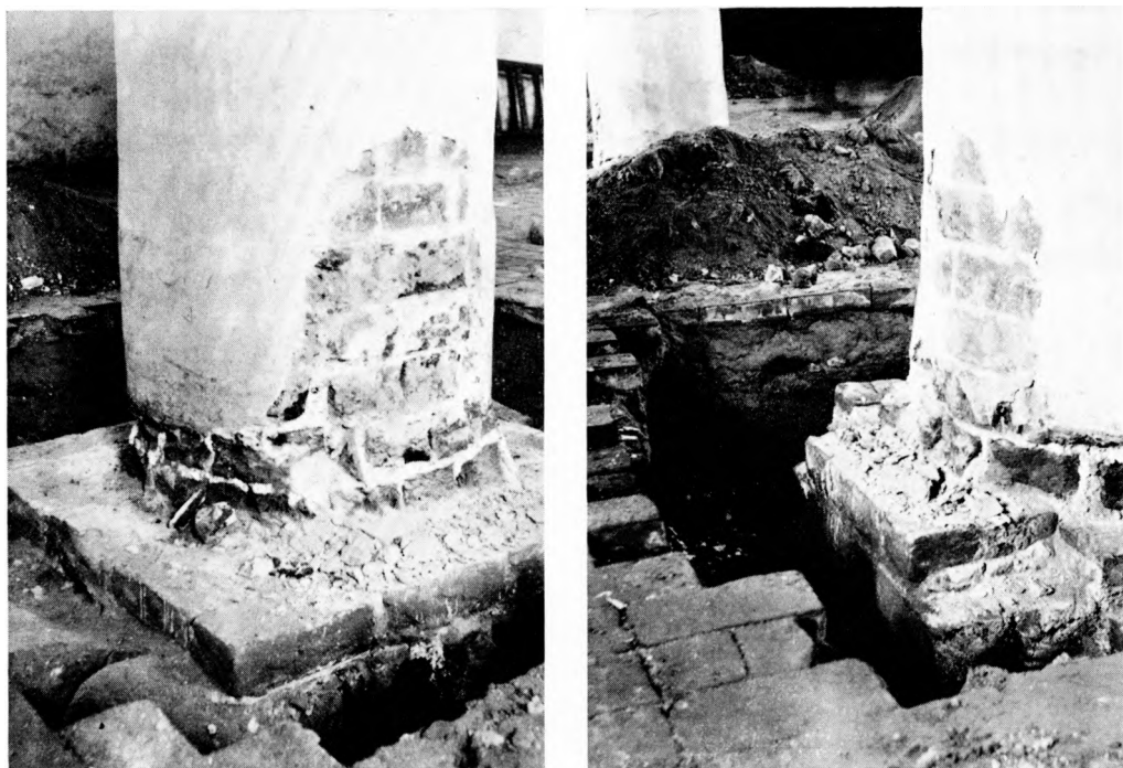
Fig. 11—12. Søborg. To af de hvælvbærende piller i skibet, ved soklens fremgravning (p. 1115).
