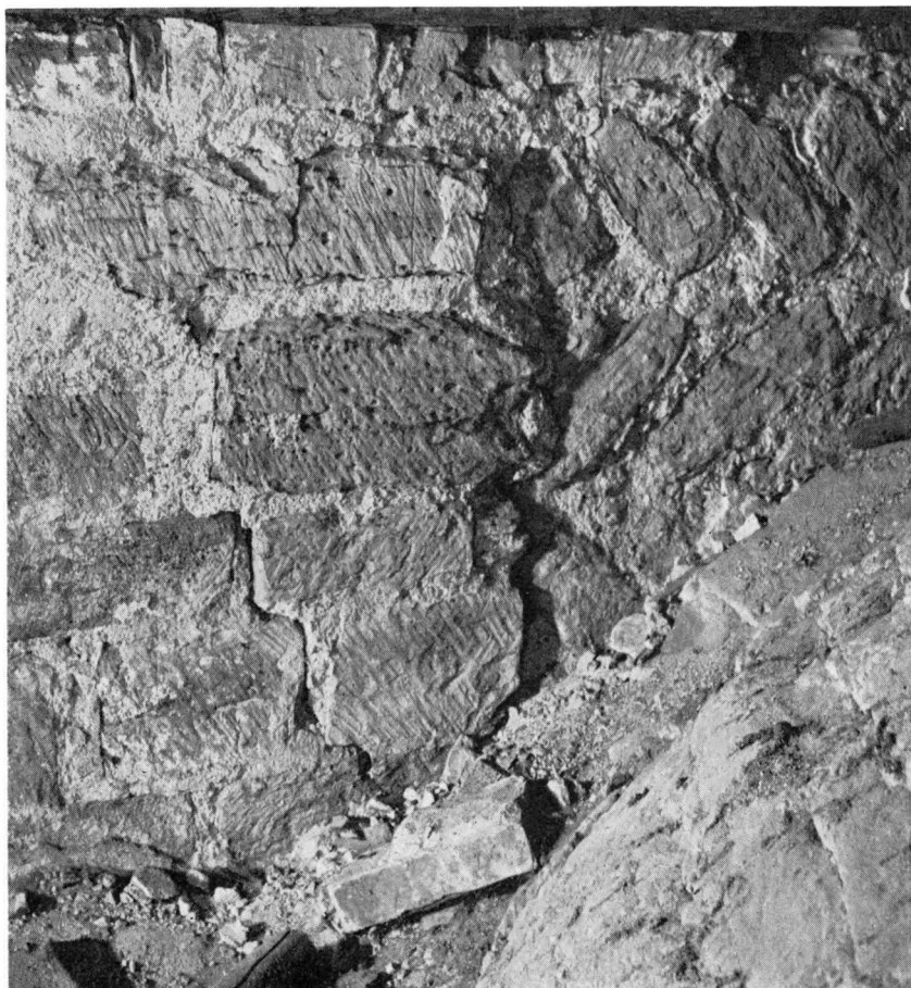
Fig. 6. Vejby. Murværk med opus spicatum i skibets sydmur, vest for triumfmuren (p. 1283f.).
