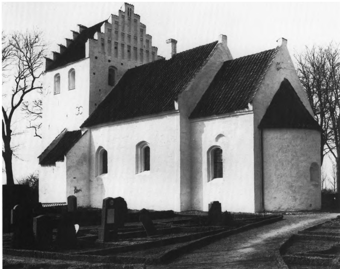
Fig. 1. Ydre, set fra sydøst. I. Arthur-Nielsen fot. 1963 eller 1966. — Exterior seen from the south-east.
