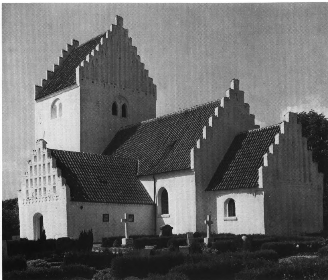
Fig. 3. Ydre, set fra sydøst. E. Kusch fot. 1963. - Exterior seen from the south-east.
