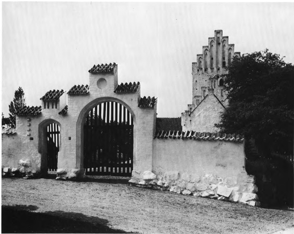
Fig. 1. Kirkegårdsportalen og kirken, set fra øst. NE fot. 1954. — Churchyard gate and church seen from the east.
