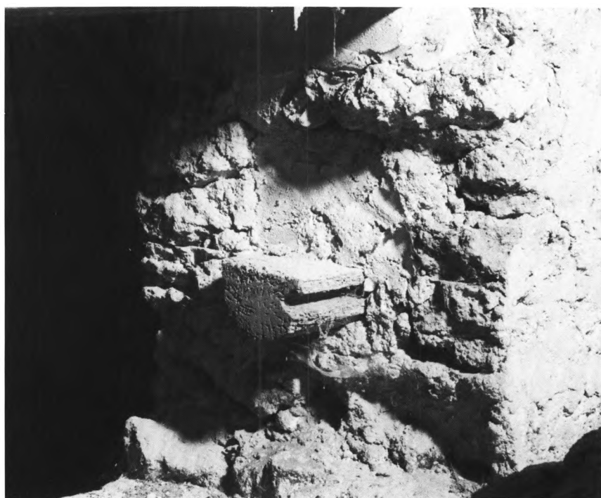
Fig. 4. Sekundær gennembrydning af korets østre taggavl, som viser frådstensmurværkets støbeteknik (s. 896) og en stavværksplanke, indlagt som ankerbjælke (s. 896). HJ fot. 1983.- Secondary passage in the east gable of the chancel, showing the technique of laying the calcareous tufa masonry, as well as a stove plank re-used as a tie beam.
