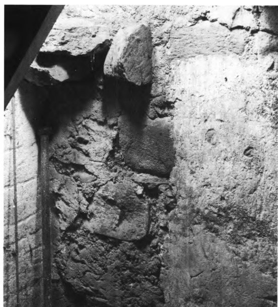
Fig. 8. Fortanding til det romanske (†)tårns nordre flankemur, set fra nuværende tårns mellemstokværk (s. 897). HS fot. 1957. - Toothing for the north wall of the Romanesque tower seen from the second storey of the present tower.
