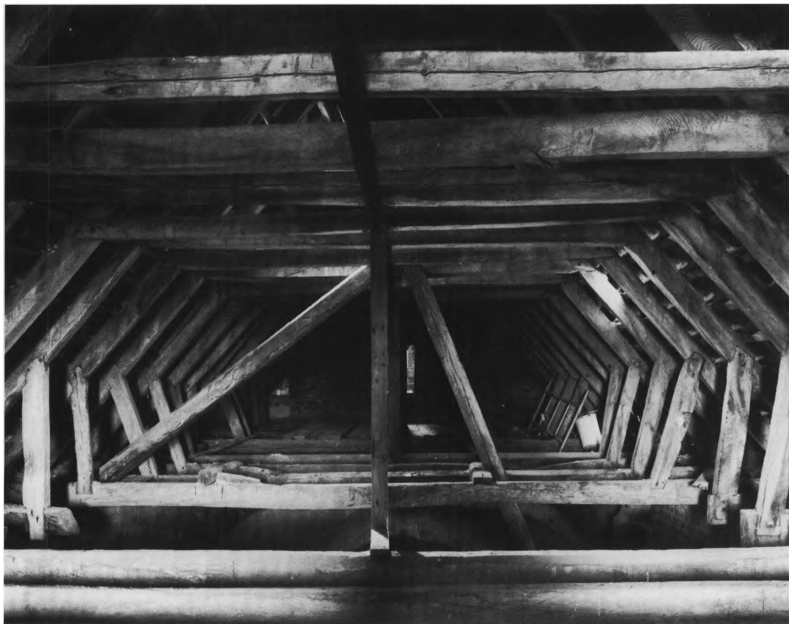
Fig. 14. Langhusets tagværk, set mod vest (s. 1127). HJ fot. 1984. - Roof structure of the church to the west.
