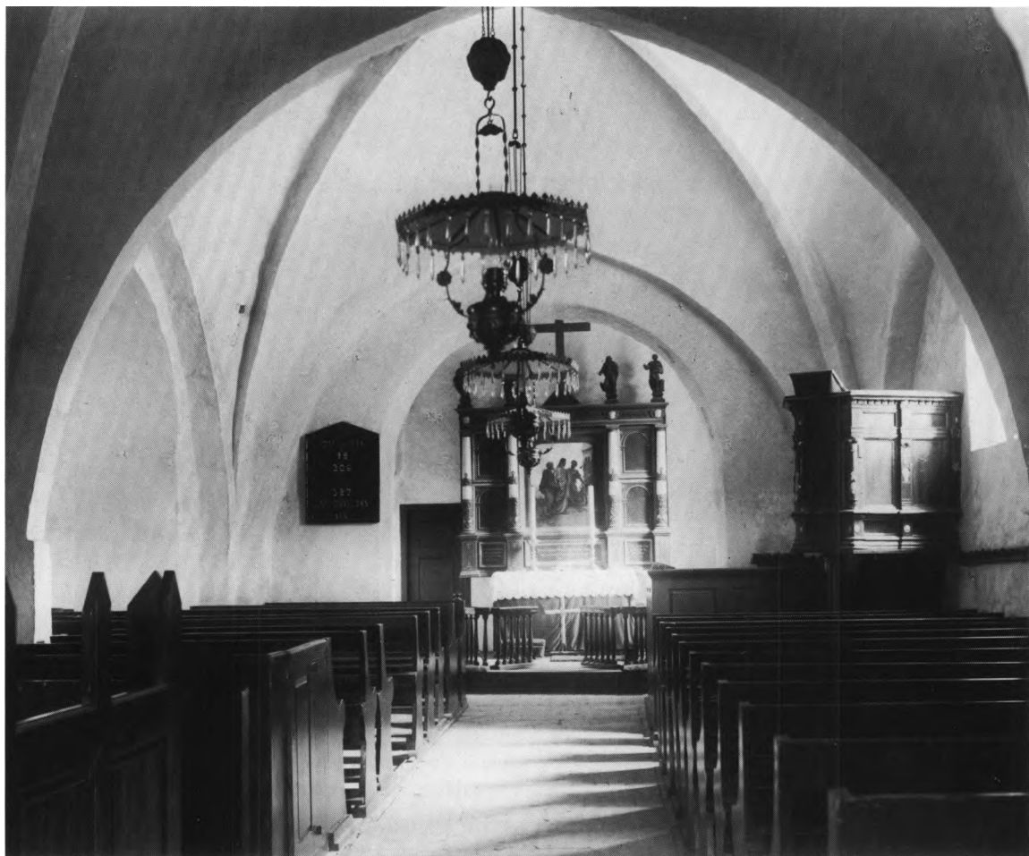
Fig. 25. Indre, set mod øst. M. Stahl fot. 1901. - Interior to the east.
