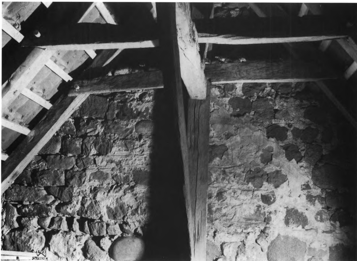
Fig. 4. Østmuren af oprindeligt tårn, set fra skibets loft (s. 1155). Til venstre skimtes sydøsthjørnets kvadre, ligesom skibets oprindelige tag står markeret af kvaderridset puds inden for de skrå taglinjer (s. 1154). HJ fot. 1984. - East wall of the original tower, seen from the nave loft. To the left can be glimpsed ashlars of the south-east corner; traces of the original roof over the nave are discernible.
