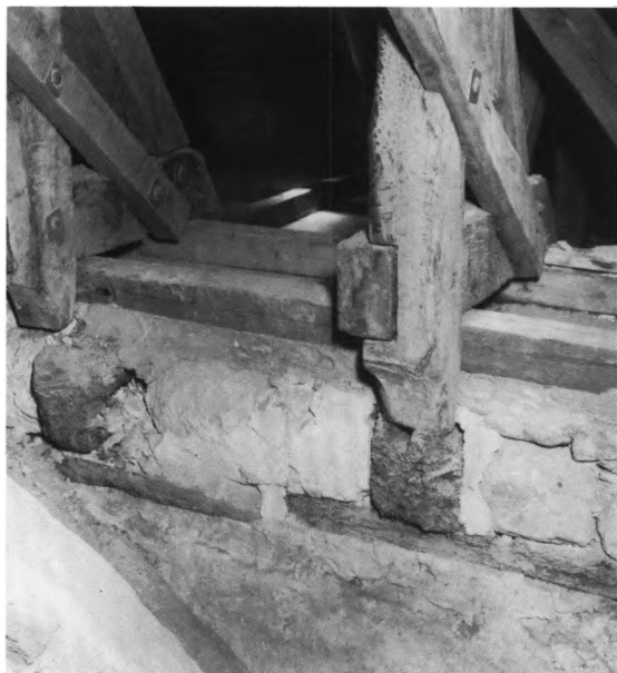
Fig. 10-11. Detaljer af skibets loft og tagværk. 10. Murkrone i nord med ender af oprindelige loftsbjælker, som afsavedes ved hvælvs-lagning (s. 1184). 11. Foden af det gotiske tagværks spær med stregnummerering ved samlingerne på østsiden (s. 1190). HJ fot. 1984. - Details of the nave loft and roof construction.
