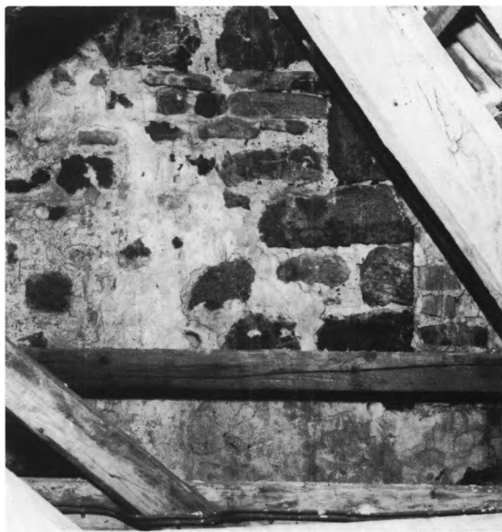
Fig. 4. Udsnit af det oprindelige (†)tårns østmur, set fra skibets loft. Bemærk nordøsthjørnets kvadre og aftryk efter skibets tag, markeret af murpudsen inden for de skrå tagflader (s. 1184). HJ fot. 1984. - Detail of the east wall of the original (†)tower seen from the loft of the nave. Note the ash-lars of the north-east corner, and traces of the pitch of the nave's original roof indicated by the plaster.
