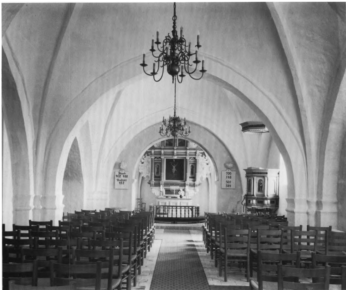
Fig. 33. Indre, set mod øst. NE fot. 1979. - Interior to the east.
