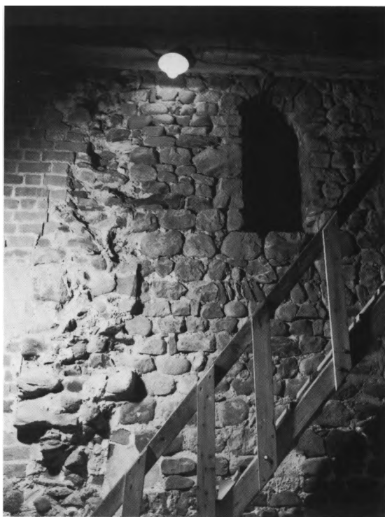
Fig. 5. Østsiden og den afbrudte nordmur af oprindeligt (†)tårn, set fra mellemstokværket i det gotiske tårn (s. 1184). HS fot. 1983. - East side and the severed north wall of the original (†)tower seen from the second storey of the Gothic tower.
