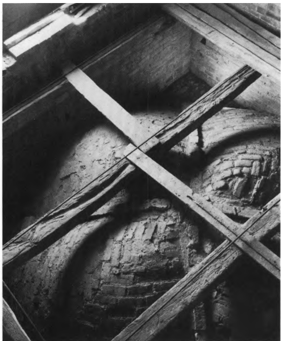
Fig. 7. Mellemstokværket i det gotiske tårn med gulvbjælker over tårnrummets hvælv (s. 1186). HJ fot. 1984. - Second storey of the Gothic tower with beams for floorboards above the vault over the tower chamber.
