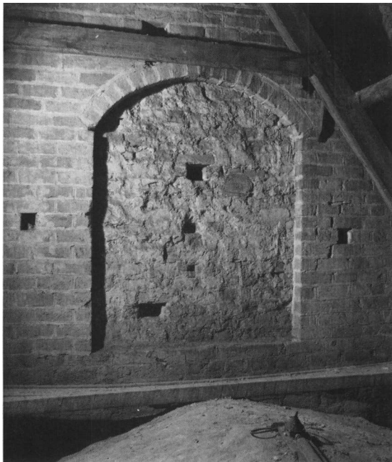
Fig. 23. Skalmur på tårnets østside (s. 1554). HJ fot. 1986. - Faced wall on the east side of the tower.
