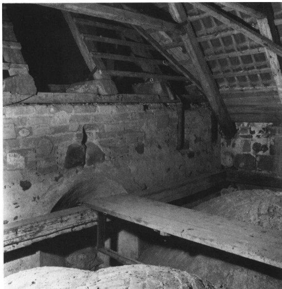
Fig. 50. Korets nordmur, set fra sakristiets loft. Vinduet og murkronen af tegl stammer fra kirkens senromanske ombygning (s. 1547). Omridset af de tilmurede huller efter udtagne lofts bjælker (s. 1544) er angivet med stiplede linjer. HJ fot. 1986. - North wall of the chancel seen from the sacristy's loft. The window and tile crown of wall date from the late Romanesque rebuilding. Outline of bricked-up beam-slots from former roof beams are indicated by dotted lines.
