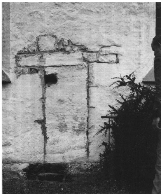
Fig. 9. Skibets oprindelige vestdør (s. 1543). Omrids af ydre åbning, blotlagt ved undersøgelse 1986. HJ fot. - Original west door of the nave. The outline of its exterior revealed during an examination in 1986.
