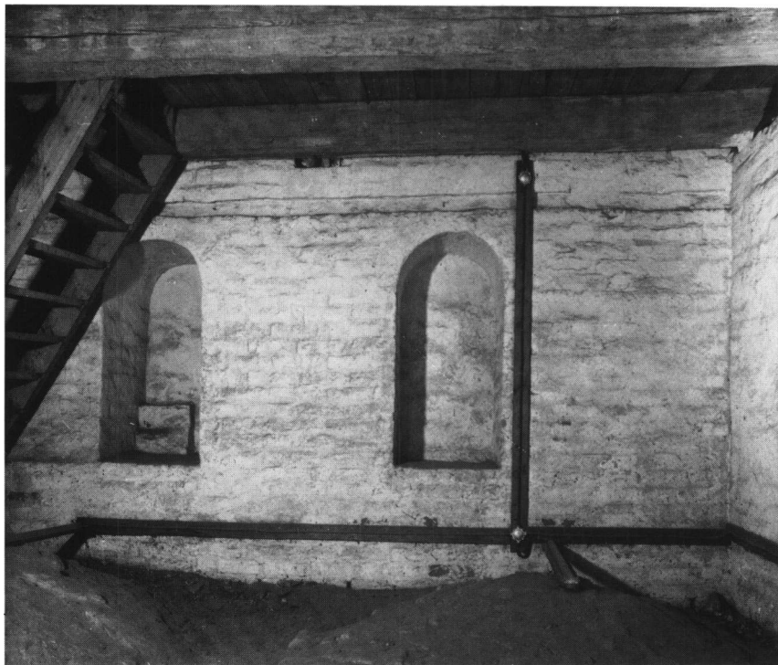
Fig. 12. Blændede åbninger til planlagt herskabspulpitur i forbindelse med kirkens senromanske ombygning (s. 1546), nu i østvæggen af tårnets 1. mellemstokværk. LL fot. 1980. - Bricked-up apertures for a manorial pew, planned in connection with the late Romanesque rebuilding. Now in the east wall of the tower's second storey.
