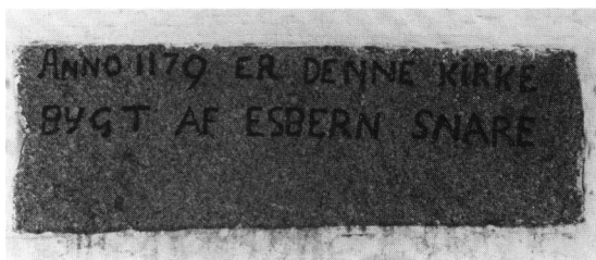
Fig. 20. Bygningsindskrift på sten, indmuret i gavlen af søndre våbenhus (s. 1552). HJ fot. 1986. - Secondary founding inscription on a stone embedded in the gable of the south porch.
