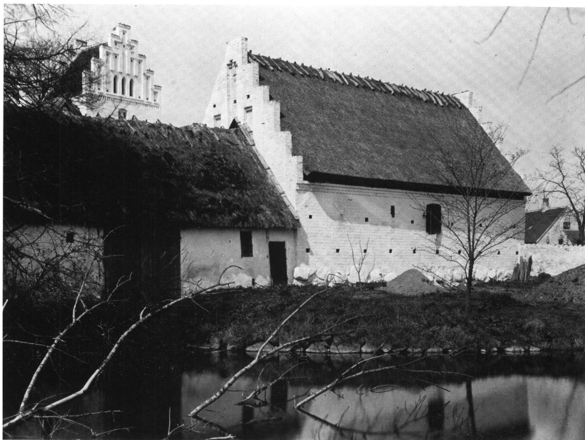
Fig. 5. Kirkelade og nedrevet præstegårdslænge (s. 1586), set fra øst. Chr. Axel Jensen fot. 1911. - Tithe barn and demolished wing of the vicarage from the east.
