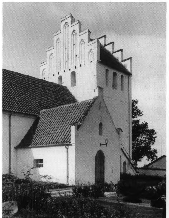
Fig. 8. Våbenhus (s. 1688) og tårn (s. 1690) set fra nordøst. NE fot. 1980. - Porch and tower seen from the north-east.
