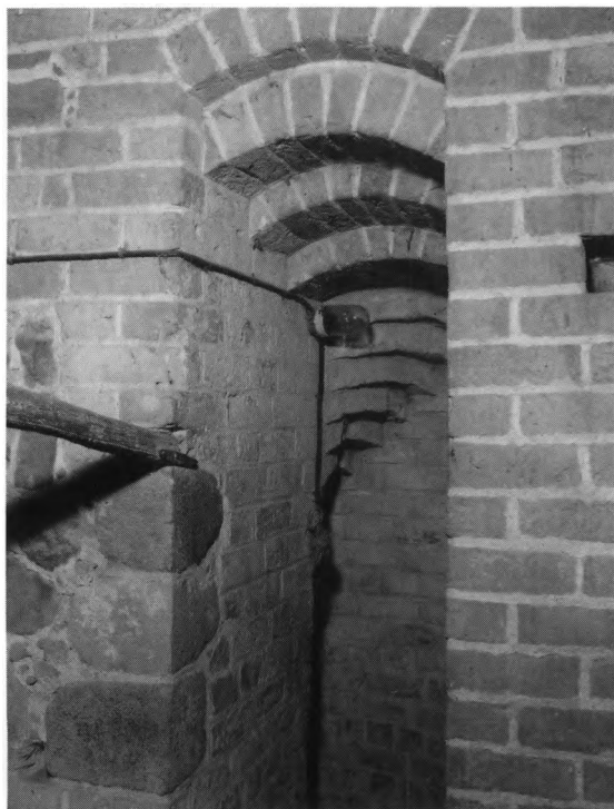
Fig. 5. Trappehusets overdør, set fra tårnets mellemstokværk. Det vestre hjørne er sat af kvadre fra kirkens oprindelige tårn (s. 1931). HJ fot. 1989. - The stair turret's upper door seen from the tower's second storey. Ashlars from the church's original tower are used in the west corner of the stair turret.
