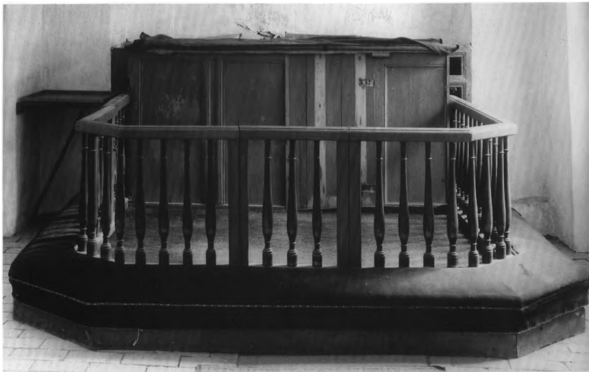
Fig. 16-17. Korets østparti fotograferet under restaureringen 1944. 16. Middelalderligt alterbord (s. 1937) efter fjernelse af panelet, og muret knæfald formentlig fra 1700'ernes slutning (s. 1946). I alterbordets overflade bemærkes dækstenen over helgengraven. Til højre for alterbordet ses skab, som efter restaureringen opstilledes i sakristiet, nu på loftet (s. 1951). 17. Alterbordet dækket af sammenstykket alterbordspanel (s. 1938) og knæfald med gelænder fra 1800'ernes første halvdel (s. 1946). Einar V. Jensen fot. 1944. - East end of the chancel photographed in the course of the restoration 1944. 16. Medieval altar after the removal of the frontal, and brick-built kneeler probably from the close of the 18th century. Notice the stone sealing the sacred relics in the altar. On the right of the altar can be seen a cupboard which was moved to the sacristy after the restoration; it is now in the loft. 17. The altar is faced by a frontal made up of several pieces; the altar rail is from the first half of the 19th century.
