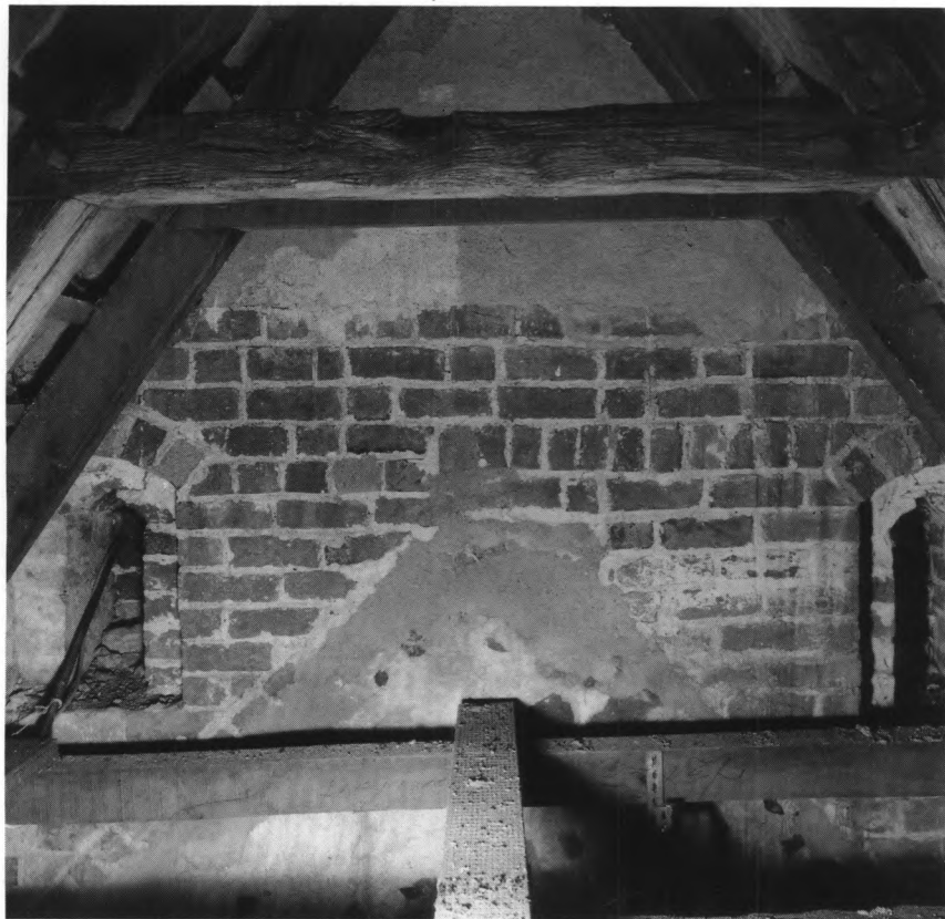
Fig. 9. Østside af tårnets første klokkestokværk, set fra skibets loft, sml. fig. 7d (s. 1966). HJ fot. 1989. - East face of the first belfry of the tower seen from the loft of the nave, cf. fig. 7d.
