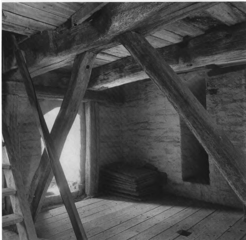
Fig. 10. Tårnets andet mellemstokværk, set mod sydvest. Tidligere tklokkestokværk fra tårnets første forhøjelse, jfr. fig. 7e (s. 1968). I bjælkerne ses udskæringer til klokkerne (s. 1968). EM fot. 1966. - The tower's third storey looking towards the south-west. Former ðbelfry from the tower's first increase in height, cf. fig. 7e. Cuts can be seen in the beams for the bells.
