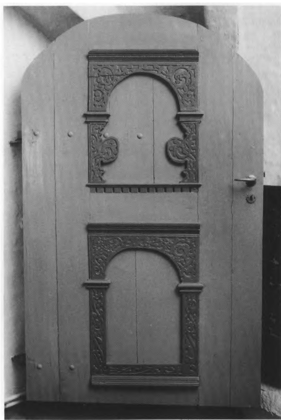
Fig. 61. Dørfloj med rammeværk fra 1600'ernes begyndelse. Mellem kor og sakristi (s. 2036). NE fot. 1987. - Door with frame from the beginning of the 17th century. Between the chancel and sacristy.
