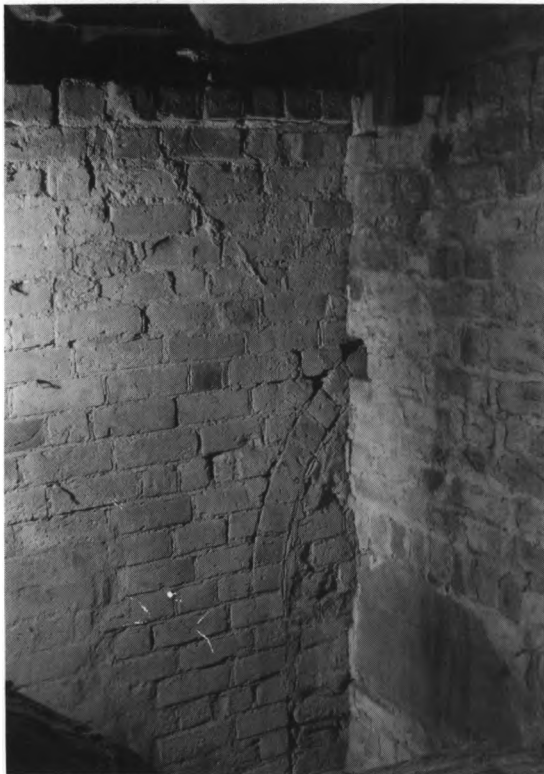
Fig. 14. Skibets sydmur, set fra kapellets loft. Over det blændede vindue (s. 2012) er den oprindelige mur forhøjet (s. 2008) og her ses spor af et tag (s. 2004) tilhørende et lavt våbenhus (s. 2005). Peter Kristiansen fot. 1989. - South wall of the nave seen from the chapel's loft. Above the bricked up window the original wall has been heightened, and here the traces can be seen of a roof belonging to a low porch.
