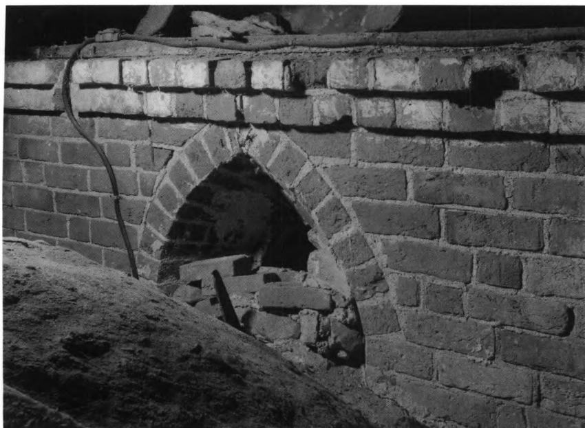
Fig. 9. Korets nordmur med oprindeligt vindue og en kalkmalet gesims (s. 2003), set fra sakristiets loft. HJ fot. 1987. - North wall of the chancel with original window and painted cornice seen from the loft above the sacristy.
