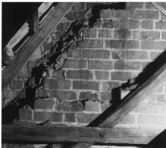
Fig. 22. Detalje af triumfgavlens vestside med spor af skibets ældste tag og gavlkam (s. 2012). Peter Kristiansen fot. 1989. - Detail of the west face of the nave's east wall with traces of the earliest roof and gable.
