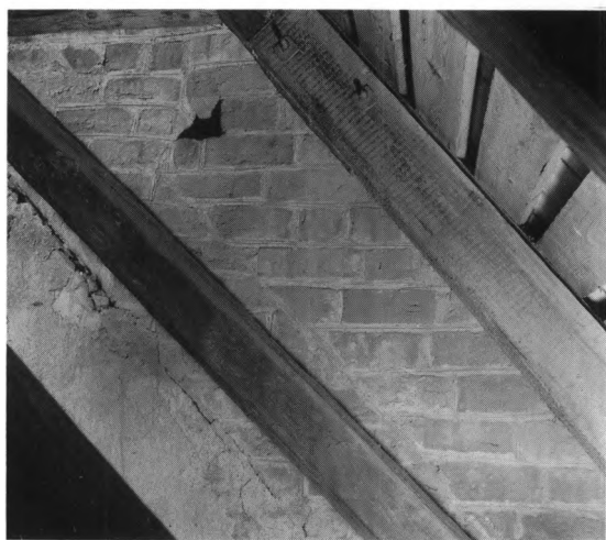
Fig. 16. Detalje af triumfgavlens østside med spor af muret, tindesmykket kam (s.2212), som sekundært er opsat på den oprindelige pudsede taggavl af marksten, sml. fig. 15. HJ fot. 1990. - Detail of the east face of the nave with traces of a pinnacled brick crest, added to the original, plastered gable of field stones, cf. fig. 15.
