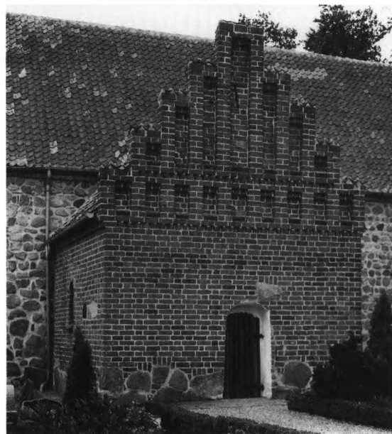
Fig. 15. Sakristiet, set fra nordøst (s. 2335). HJ fot. 1982. - Sacristy seen from the north-east.
