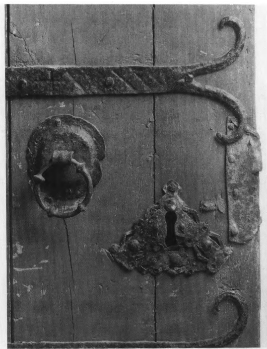
Fig. 41b. Detalje af senmiddelalderlig *dørfløj, sml. fig. 41a. Oprindelige smedejernsbeslag, låseblok og dørning (s. 2358). NE fot. 1990. - Detail of late medieval *door. Original wrought iron fittings, lockplate and ring, cf. fig. 41a.
